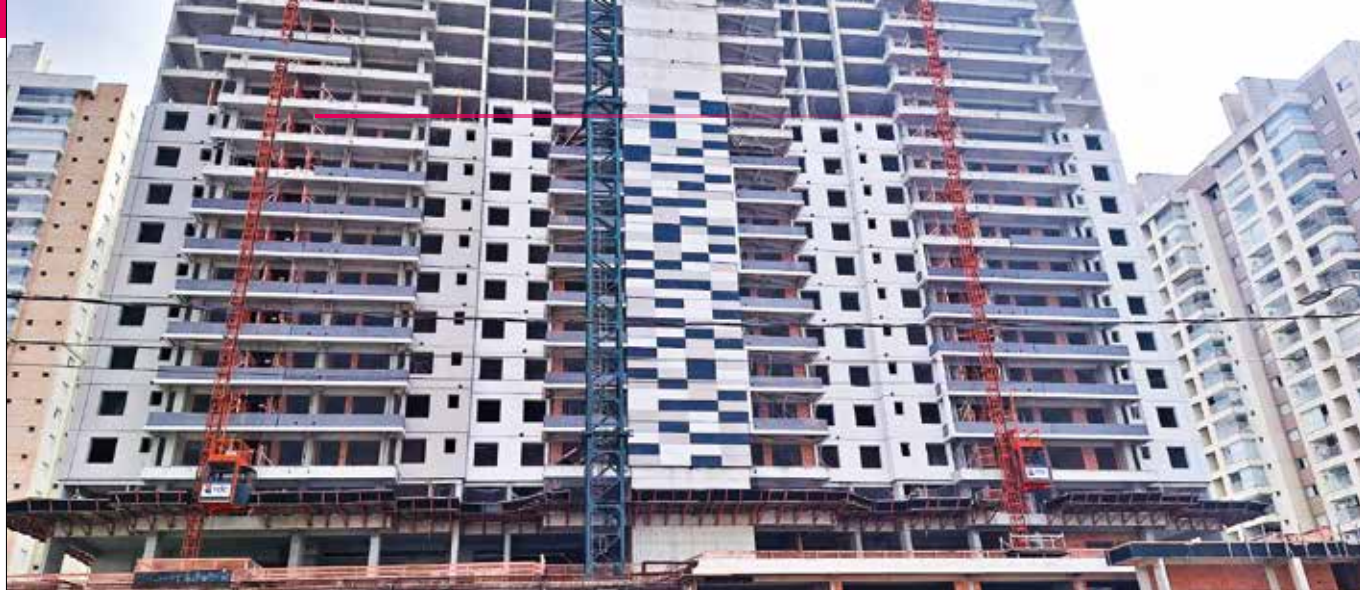
Edifício Quadria, em São José dos Campos, cujos painéis de fachada, regulares e bem acabados, usam aditivos para sua produção. Crédito: Banco de Imagens da ABCIC
