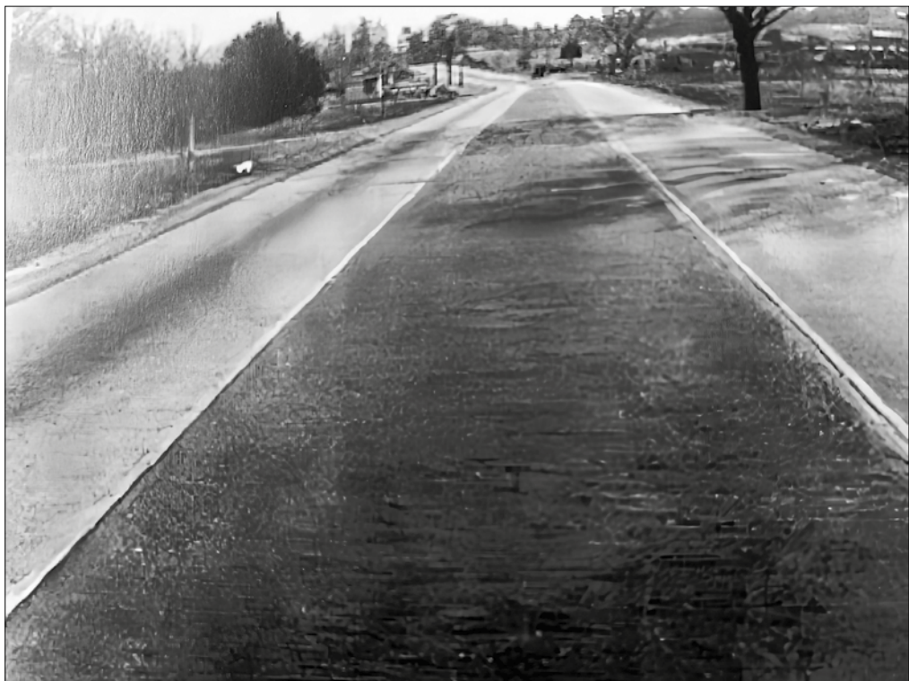
Imagem do primeiro pavimento de concreto com emprego de aditivo incorporador de ar sintético. Fonte: Arquivo W. R. Grace (apud: ISAIA, 2011)
