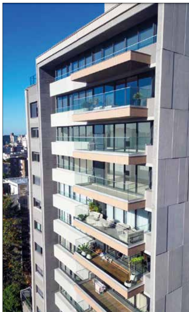
Fachadas pré-fabricadas do Almirante Green Residence, em Porto Alegre, cujo acabamento foi facilitado pelo uso de aditivos no concreto.
