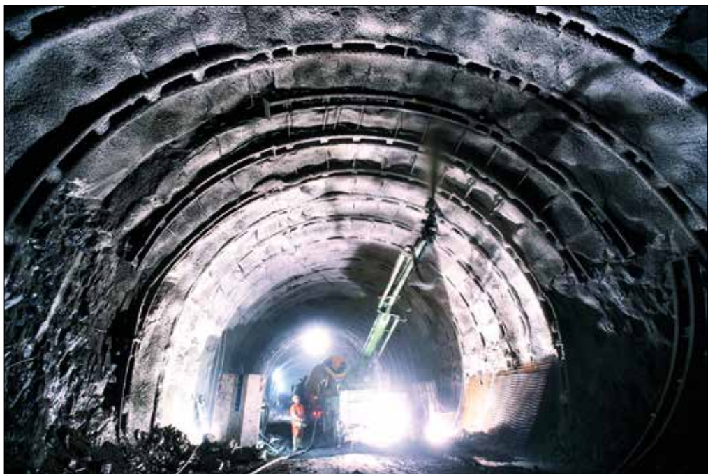
Concreto projetado para revestimento de túnel, tecnologia que se viabilizou a partir do desenvolvimento dos aditivos
