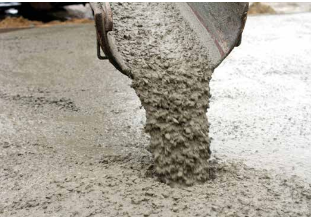
Concreto autoadensável, que se tornou possível com o uso de aditivos superplastificantes com policarboxilato, sendo lançado
