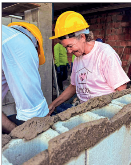
Artesã assenta bloco de concreto da nova sede
