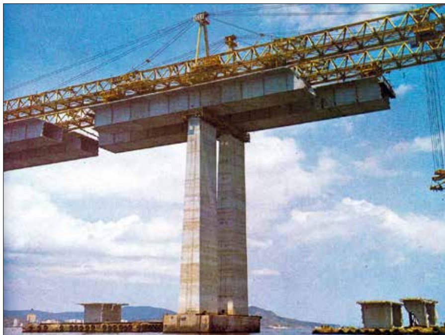
Montagem de aduelas pelo processo dos balanços sucessivos no Trecho sobre o Mar
