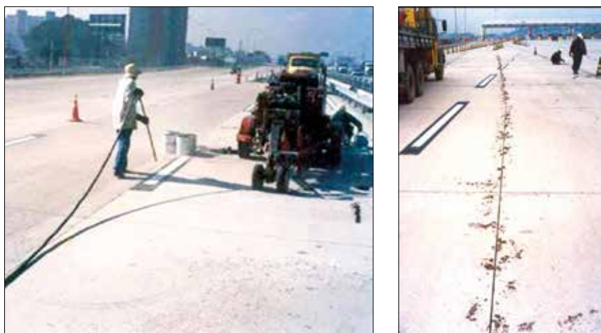
FIGURA 28 LIMPEZA E ALARGAMENTO DE JUNTAS
