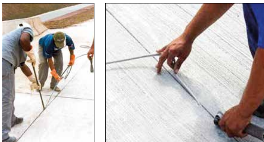
FIGURA 29 COLOCAÇÃO DE JUNTAS PRÉ-FABRICADAS
