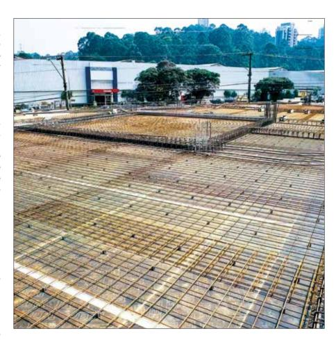
O resultado dessa ação resultou em 4 novas séries de telas de aço soldadas nervuradas (166, 238, 385 e 709) que, consequentemente, substituíram as 4 séries (159, 246, 396 e 636).
