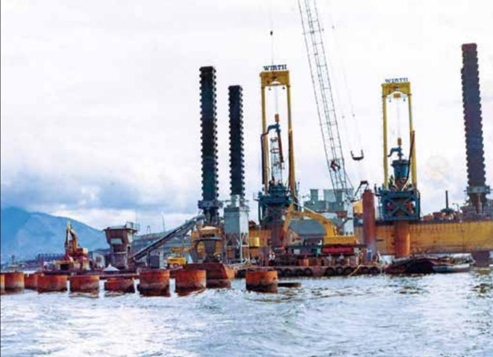
Conjunto Ilha Flutuante e Equipamento Entubador e Perfurador, atuando na construção de tubulões tipo *Bade-Wirth*
