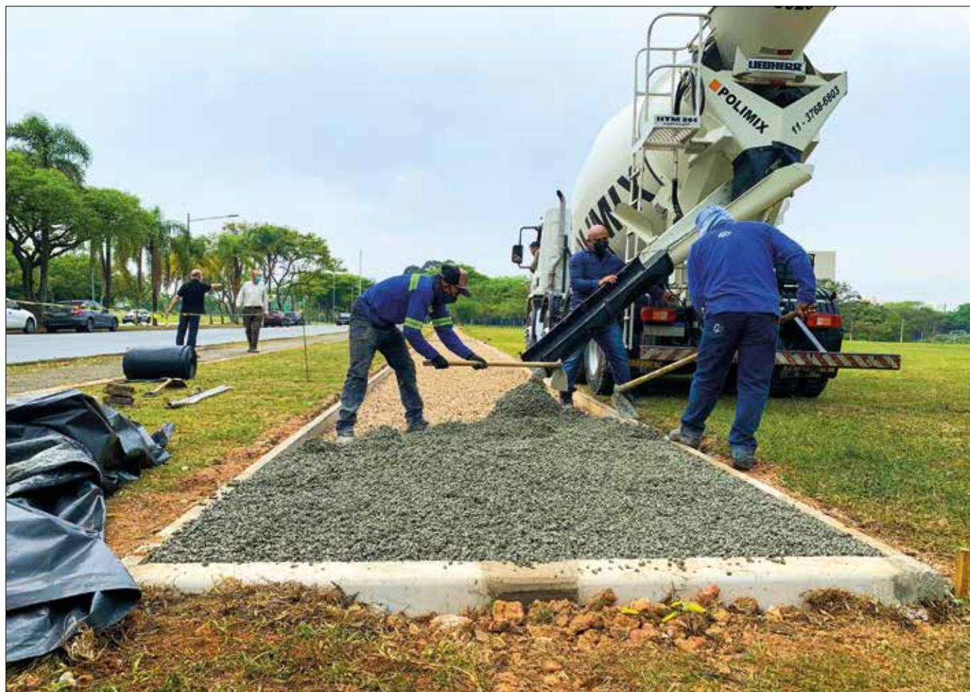
Foto 1 – Execução de pavimento permeável com lançamento do concreto de consistência seca
