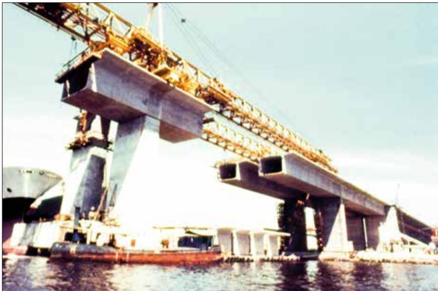
**Figura 7 — Montagem das aduelas com treliças metálicas**
