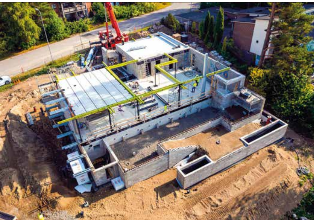
Pórticos de carga desmontáveis e reutilizáveis através de estruturas compostas e pré-fabricadas de betão. Cortesia da Peikko
