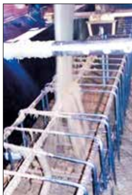
FIGURA 12 ARMADURA POSICIONADA E LANÇAMENTO E ADENSAMENTO DO CONCRETO FONTE: PRÓPRIO AUTOR (2017)
