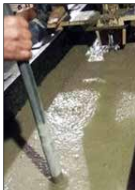
FIGURA 12 ARMADURA POSICIONADA E LANÇAMENTO E ADENSAMENTO DO CONCRETO FONTE: PRÓPRIO AUTOR (2017)
