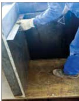
FIGURA 10 INSPEÇÃO DA GEOMETRIA E DIMENSÃO DAS FÔRMAS FONTE: PRÓPRIO AUTOR (2017)
