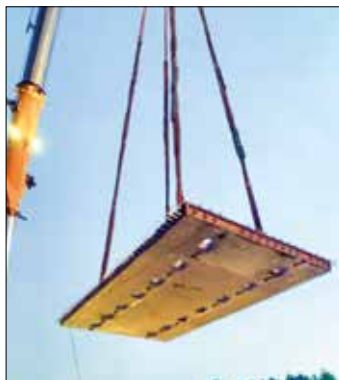
FIGURA 2 TABULEIRO FORMADO POR PAINEL PRÉ-MOLDADO FONTE: AURIER et al. (2023)
