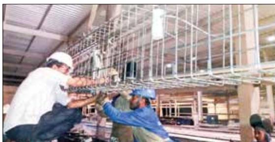
FIGURA 11 POSICIONAMENTO DA ARMAÇÃO
