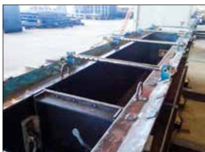
FIGURA 9 PREPARO DAS FÔRMAS E LOCAÇÃO DOS GABARITOS FONTE: PRÓPRIO AUTOR (2017)
