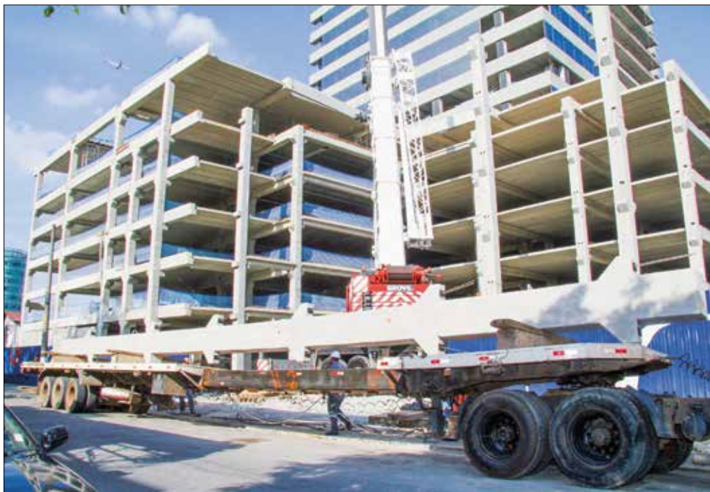
Montagem de estrutura pré-fabricada com peças produzidas na indústria (off-site)
