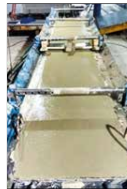
FIGURA 12 ARMADURA POSICIONADA E LANÇAMENTO E ADENSAMENTO DO CONCRETO FONTE: PRÓPRIO AUTOR (2017)
