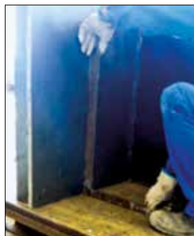
FIGURA 10 INSPEÇÃO DA GEOMETRIA E DIMENSÃO DAS FÔRMAS FONTE: PRÓPRIO AUTOR (2017)
