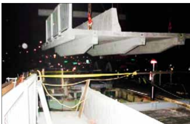
FIGURA 3 SUPERESTRUTURA MODULAR SENDO INSTALADA NA PONTE JACQUES-CARTIER FONTE: AURIER et al. (2023)
