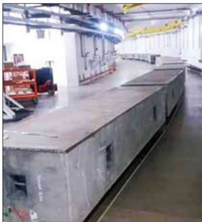
FIGURA 19 BASES INSTALADAS NO LABORATÓRIO SIRIUS PARA MONTAGEM DO CONJUNTO DE ELETROÍMÃS FONTE: PRÓPRIO AUTOR (2017)
