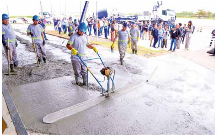
Concretagem e acabamento de pavimento de concreto no Centrosul
