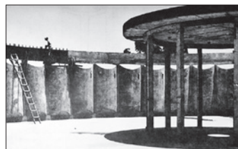
B Vista interna - construção
