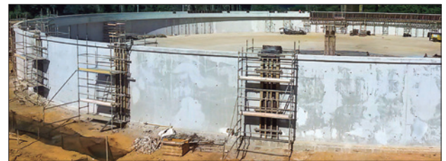
FIGURA 15 EXECUÇÃO DA PAREDE EXTERNA DO CLARIFICADOR SECUNDÁRIO
