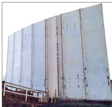
B Montagem da parede externa
