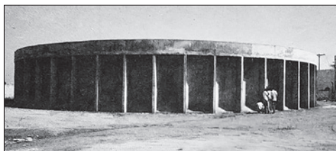
A Vista externa - construção
