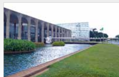
► Figura 3 Fachada do Palácio do Itamaraty, Brasília Fonte: Foto do autor
