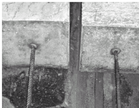
Figura 6 – Deslizamento da barra de aço
