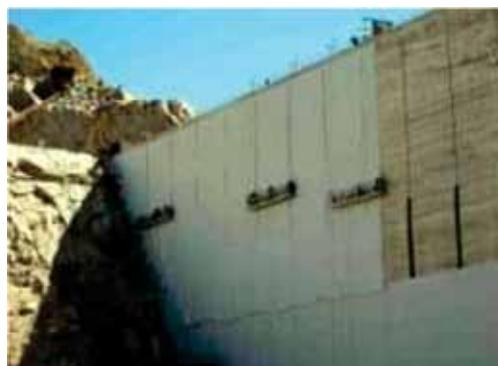
dicional, na crista e no corpo da barragem, é garantida através da instalação de veda-juntas apropriados, expostos, do mesmo material da membrana, que
