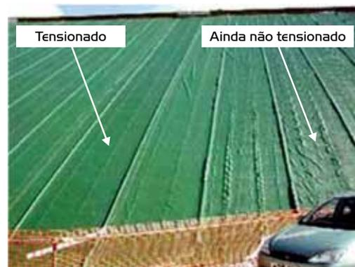
O efeito do tensionamento é visível: no lado direito, os dois perfis ainda não foram acoplados e o geocomposto está frouxo; no lado esquerdo, os dois perfis já estão acoplados e o geocomposto está esticado e sem dobras.
