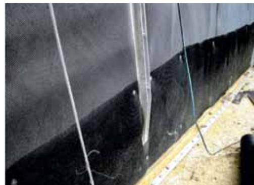
Foto 4 – Detalhe da georrede de drenagem; Olivenhain, barragem de CCR, 97 m de altura, EUA 2003
