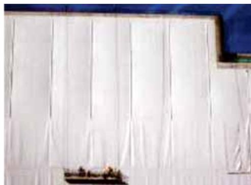
Fotos 10 e 11 – Selos superior e inferior na barragem de CCR de Balambano, Indonésia
