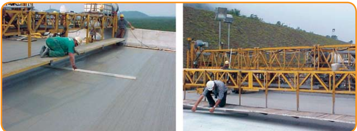
Foto 6 – Verificação de bump durante a execução
