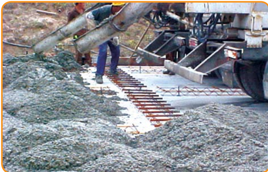
Foto 9 – Barras de transferência e ligação
