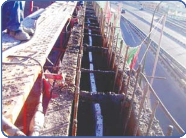
Figura 20 – Hormigonado del muro exterior (hacia los pasos superiores)
