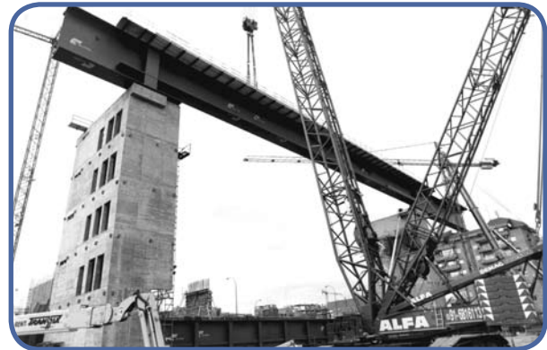
Figura 12 – Izado de una de las vigas longitudinales mediante grúas. Obsérvese que, adosado a la viga, se encuentra ya el encofrado del voladizo
