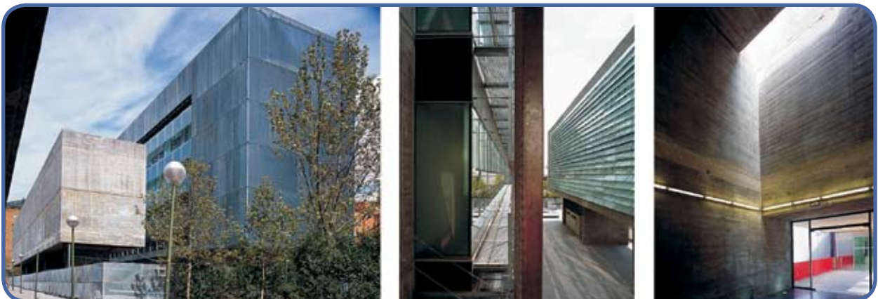
Figura 22 – Diferentes aspectos del conjunto terminado
