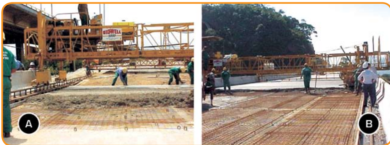
Foto 7 – Pavimento sobre Viadutos - Situação inicial da tela sobre espaçadores plásticos (A) e a substituição por cavaletes fixados à laje e tela de maior rigidez (B) para mantê-la 4 cm abaixo do nível da superfície de rolamento
