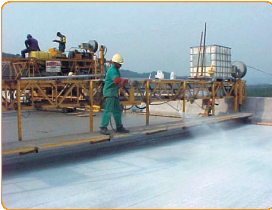
Foto 2 – O produto de cura aplicado sobre o concreto pobre rolado. Substituiu a lona e emulsão asfáltica.
