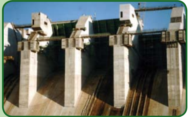
UHE Mascarenhas de Moraes, Ibiraci - MG. Estruturas seguras e resistentes aos elevados esforços incidentes nestes elementos.
