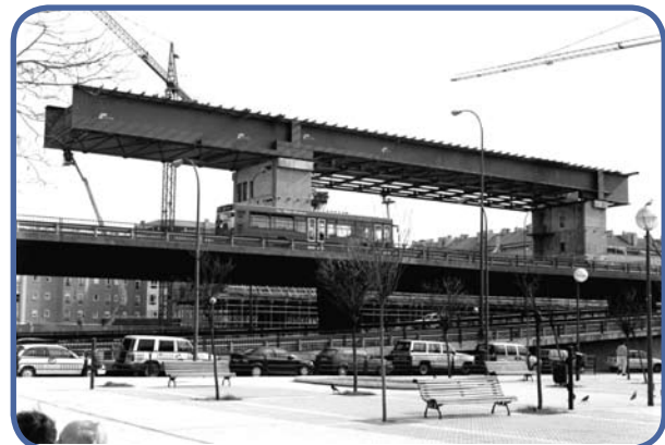
Figura 13 – Vista del conjunto cuando se ha montado el primer forjado metálico bajo cubierta
