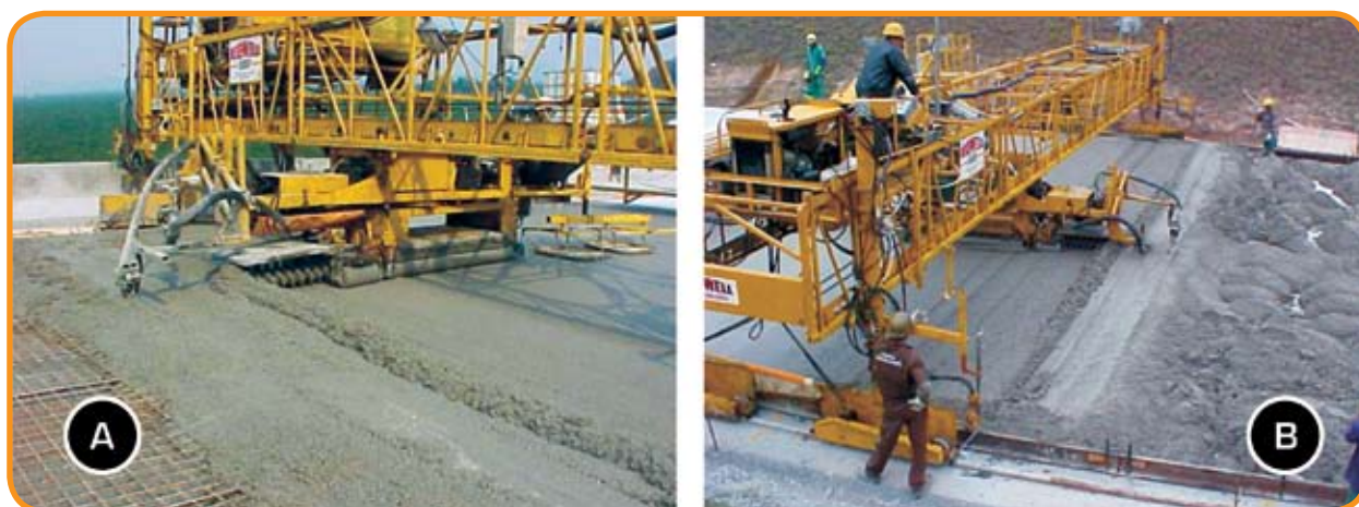
Foto 4 – Detalhes da pavimentadora trabalhando sobre viaduto (A) e trecho em terrapleno (B)
