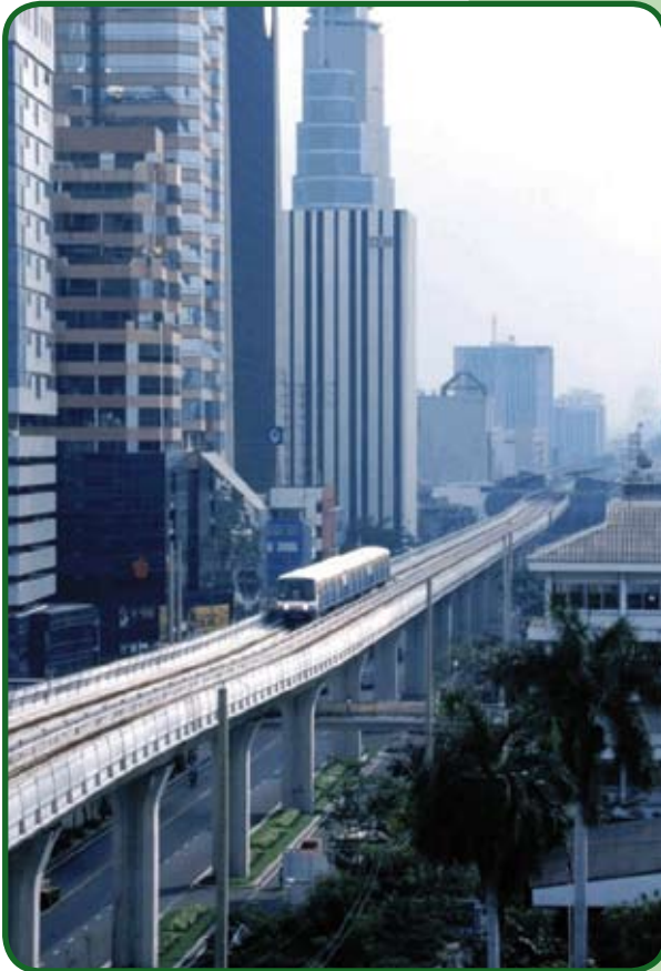
Sistema de transporte coletivo, Bangkok, Tailândia. Geometrias complexas, sobrecargas elevadas, grandes vãos, flechas reduzidas e longa vida útil.
