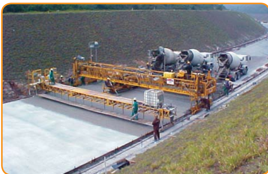
Foto 8 – Equipamento de lançamento de concreto sobre viadutos - trecho com tela
