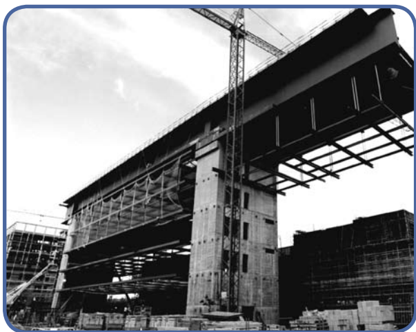
Figura 14 – Vista del conjunto en la fase de montaje descendente de forjados metálicos
