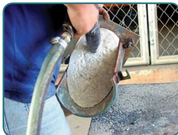
Figura 2 – Apicoamento do Concreto Velho
