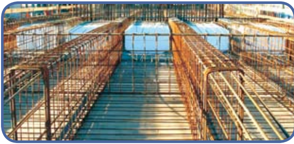
Figura 19 – Ferralla y hormigonado de la planta primera
