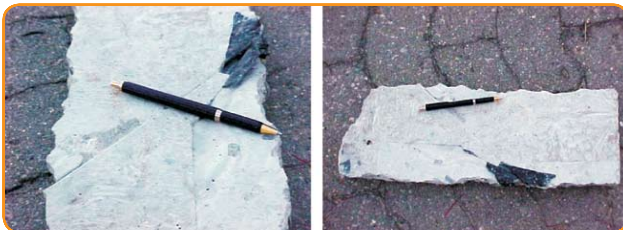
Foto 1 – Interferência da lona no concreto da placa
