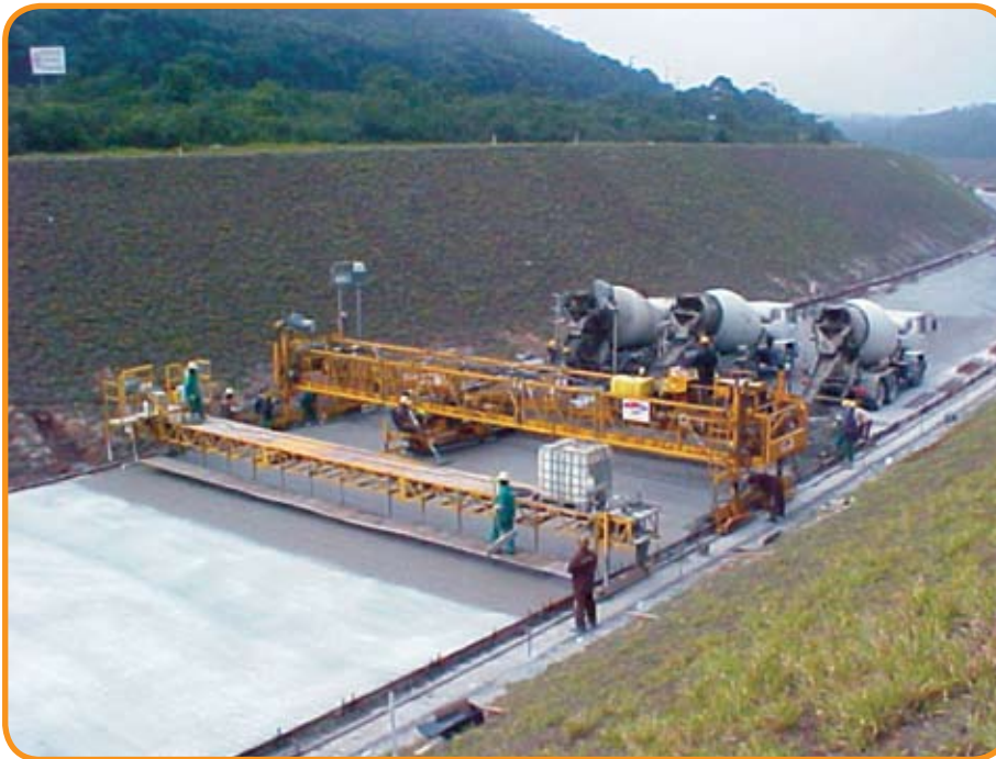
Foto 5 – Vista geral da pavimentadora trabalhando em toda a largura da pista
