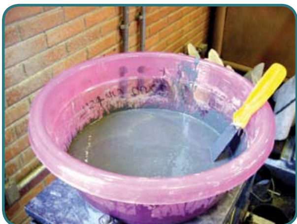
Figura 5 – Preparação do adesivo
