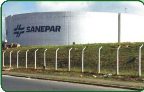
Reservatório de água, Colombo - PT. Paredes esbeltas e impermeáveis, podendo tornar desnecessária sua impermeabilização.
