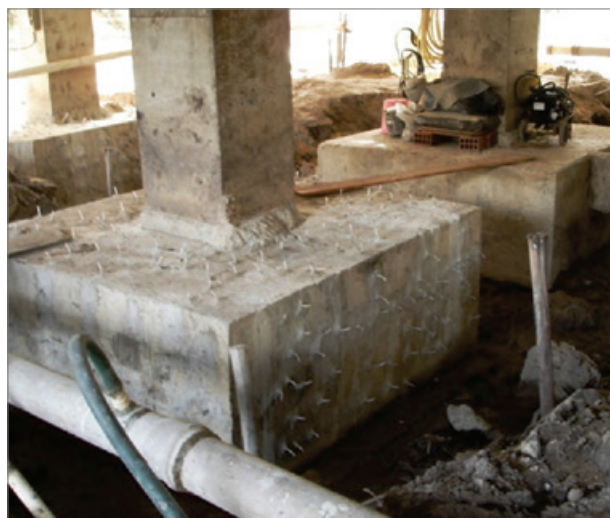
Figura 4 – Os 2 blocos idênticos, o primeiro com as fissuras colmatadas para a etapa de injeção e, o segundo, ao fundo, totalmente íntegro (foto à esquerda). Foto à direita, o bloco com a fissura horizontal acima da ancoragem dos tirantes
