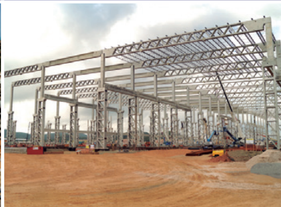
ESTALEIRO ENSEADA DO PARAGUAÇU
