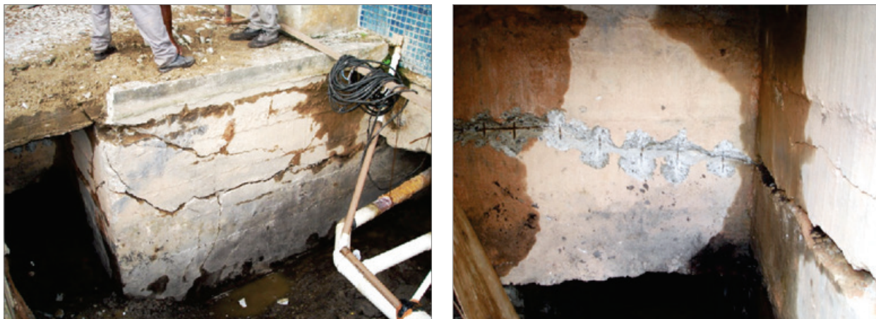
Figura 6 –Bloco fissurado lateralmente, a laje armada na superfície do bloco e a cinta apoiada nesse bloco fendilhada, com ruptura de 5 estribos próximos ao apoio
