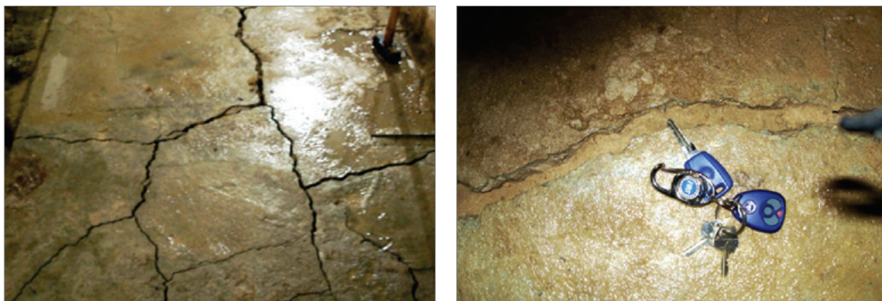
Figura 3 – Superfície superior de um bloco de coroamento com abertura máxima de fissura na ordem de 30 mm
