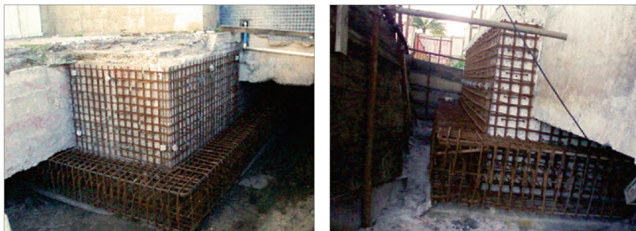
Figura 7 – Solução adotada no segundo caso, com introdução de cintas protendidas em todo perímetro do bloco, localizado na região inferior desses elementos
