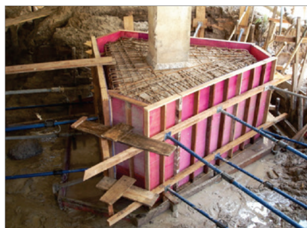
Figura 5 – Alternativa de intervenção com injeção de epóxi, apicoamento e encapsulamento do bloco com concreto armado
