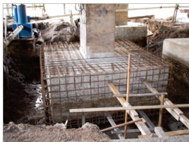
Figura 5 – Alternativa de intervenção com injeção de epóxi, apicoamento e encapsulamento do bloco com concreto armado
