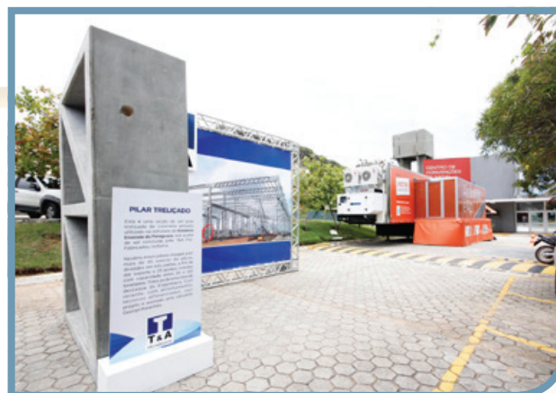
Parte do pilar treliçado usado na estrutura do Estaleiro Enseada do Paraguaçu apresentado pela T&A Pré-Fabricados no evento
