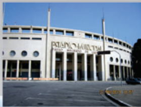
recuperação e reforço de edificações
