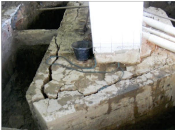
Figura 8 – Bloco bastante deteriorado na sua face superior, com deslocamento relativo de uma camada de concreto de uma das faces (esquerda)
