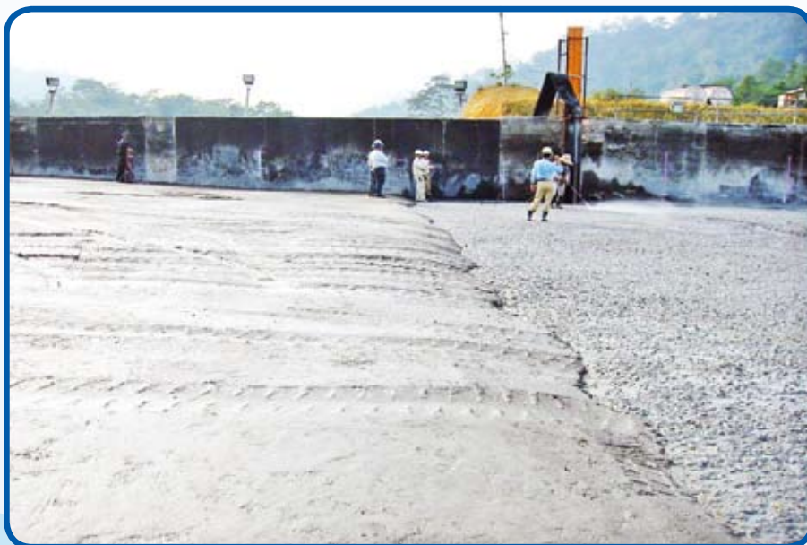
Detalhe da concretagem do método construtivo CCR rampado
