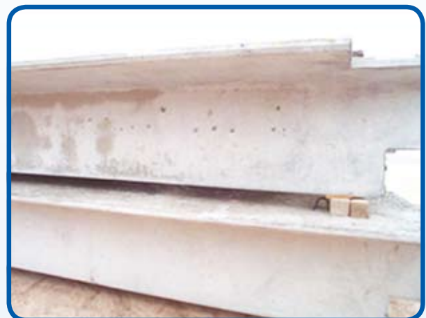
Peça pré-moldada com concreto convencional sobre peça pré-moldado com CAA
