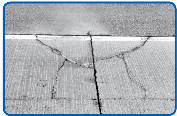
Detalhe de painéis onde se verifica as fissuras transversais e as quebraduras de canto
