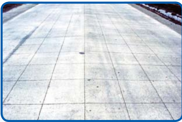
Placas de whitetopping ultra-delgado usado na recuperação de pavimento
