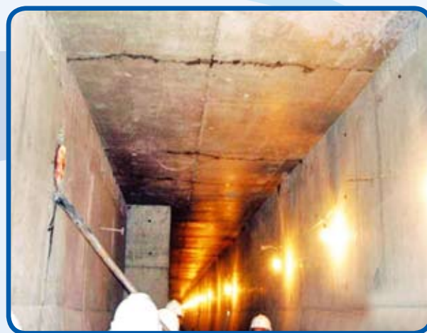
Detalhe da galeria, onde se visualiza as fissuras estruturais, apresentado no Painel
