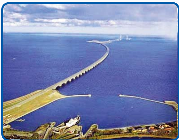
Grande Cinturão, na Dinamarca, onde foi usado concreto com microssilica
