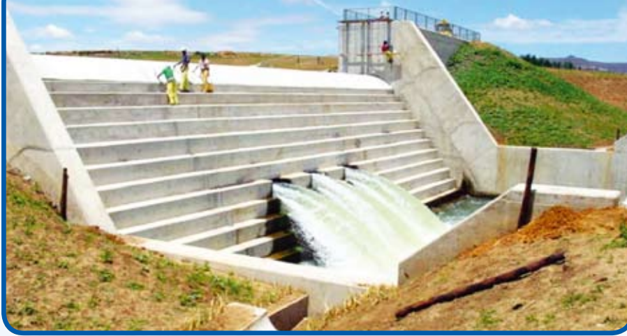
Vertedouro de 12,5m da Barragem de Botterkloof, na África do Sul
