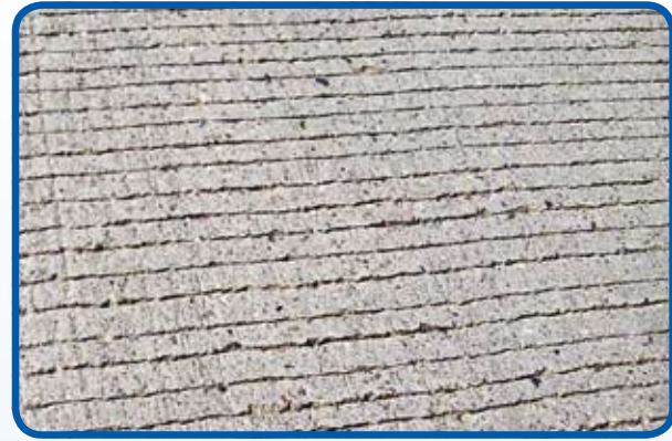
Detalhe de ranhuras transversais feitas no pavimento rígido
