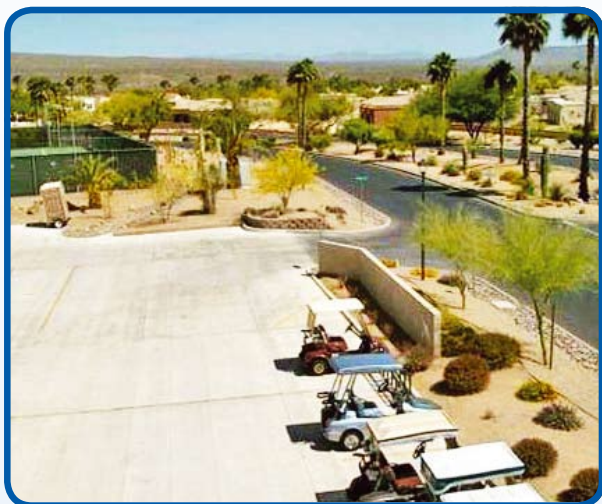
Pavimento rígido usado em estacionamento de veículos
