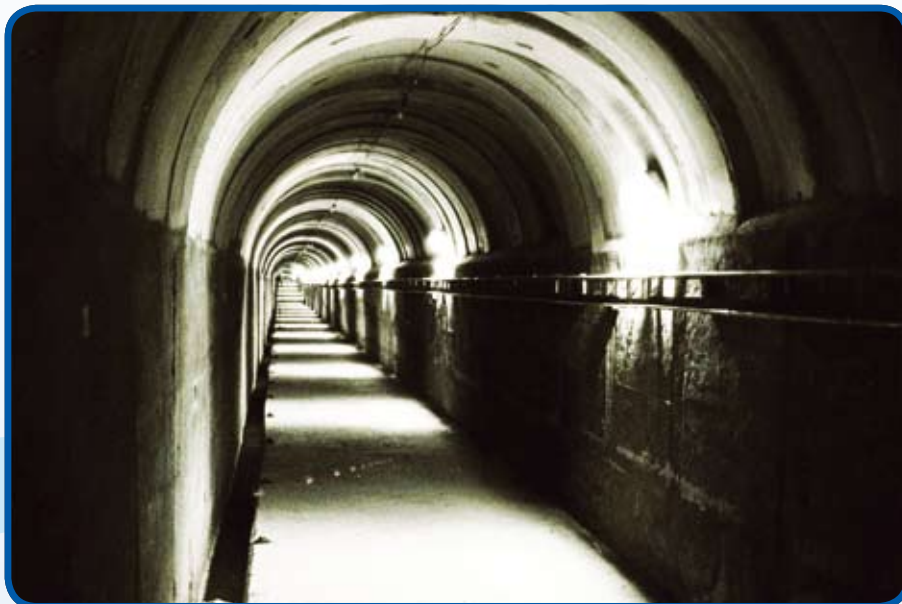
Galeria bem acabada e com boa iluminação construída com arcos pré-fabricados
