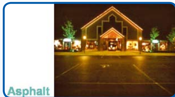
Visão noturna de pavimento asfáltico
