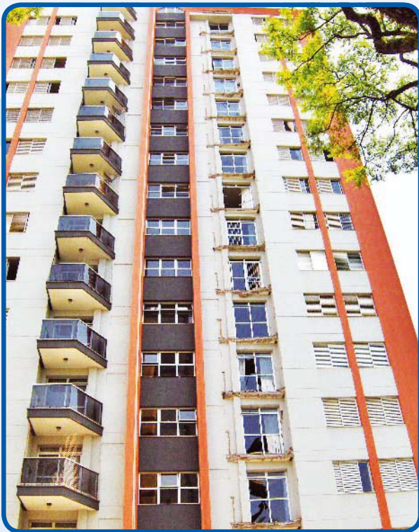
Sacadas de 15 andares do Edifício Dom Gerônimo desabaram com a queda da sacada do 15º andar
