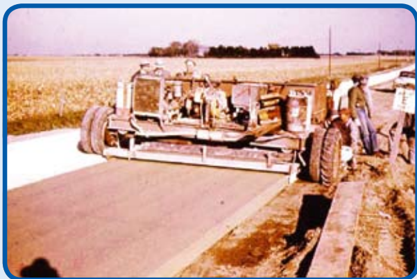
Travelling mixer em ação na construção de pavimento de concreto
