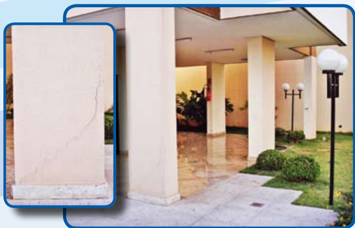
Pilar rompido pelos esforços estruturais na edificação
