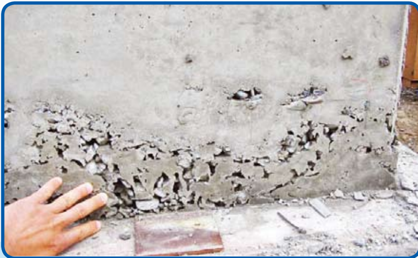
Falha de concretagem conhecida como colmeia de abelha
