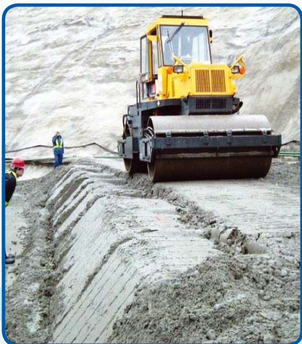
Detalhe mostrando a compactação de camadas sucessivas de CCR
