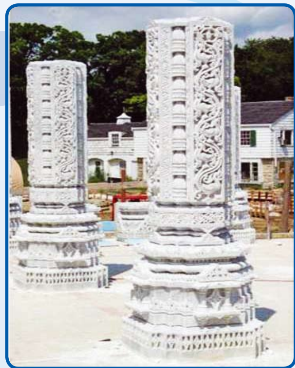
Detalhe das colunas brancas do Templo, onde foi usado o concreto composto ternário
