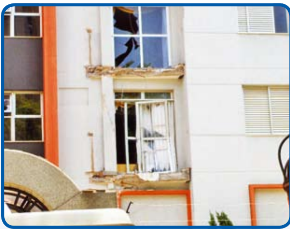
Detalhe da fachada do Edifício Dom Gerônimo, em Maringá, Paraná
