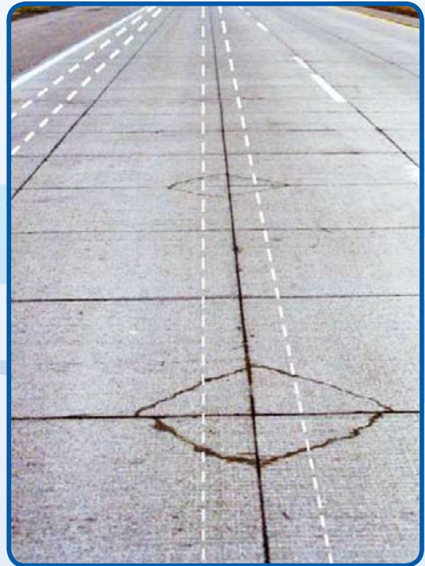
Distribuição das quebraduras de canto no whitetopping ultradelgado
