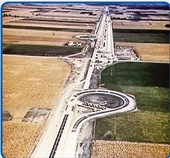
Vista aérea da AASHO Road Test, onde se vê dois de seus loops
