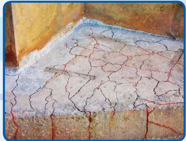
Bloco de fundação com fissuras causadas pela RAA
