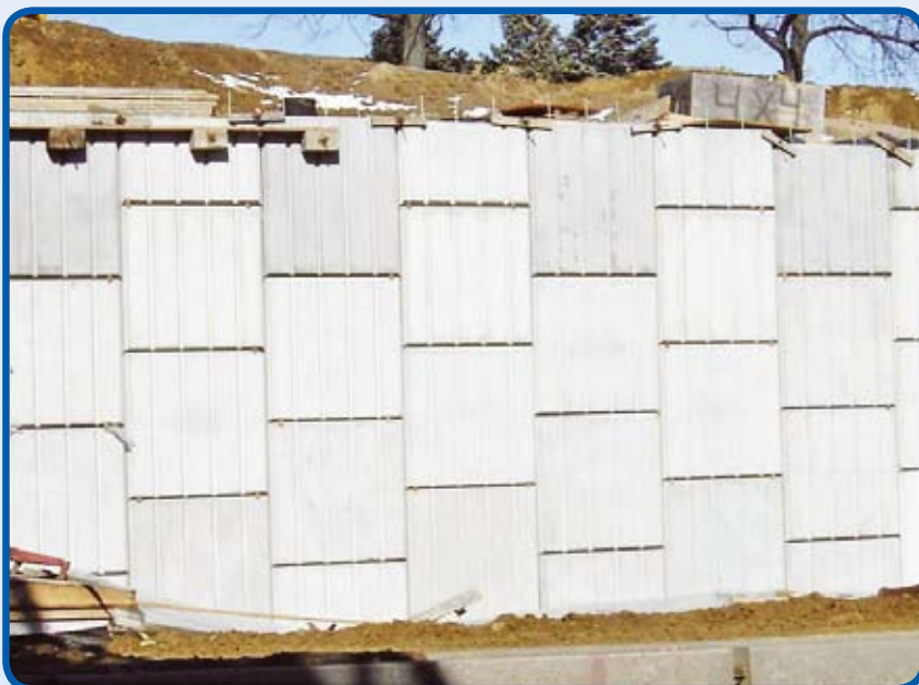
Detalhe de fachada construída com painéis pré-moldados de CAA
