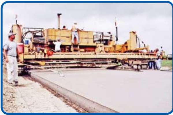
Self-propelled track-mounted paver realizando o trabalho de acabamento do pavimento de concreto
