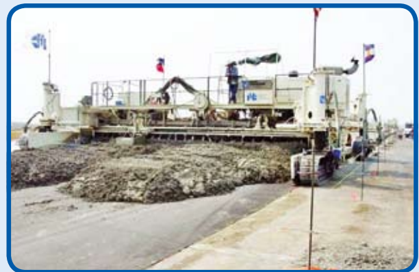
Self-propelled track-mounted paver espalhando o concreto para pavimentação
