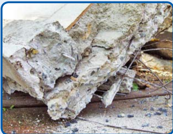
Detalhe estrutural de uma das sacadas do acidente em Maringá, ocorrido em 26 de outubro
