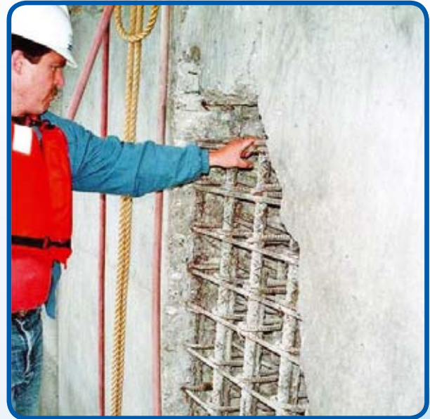
Detalhe de falha de concretagem por conta da dificuldade do concreto em penetrar parede densamente armada
