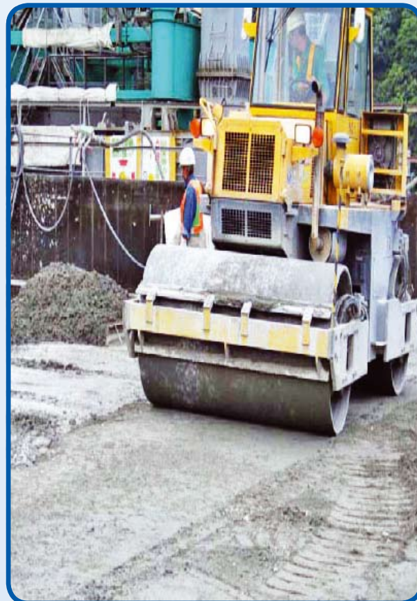
Compactação do CCR por trator de rolo
