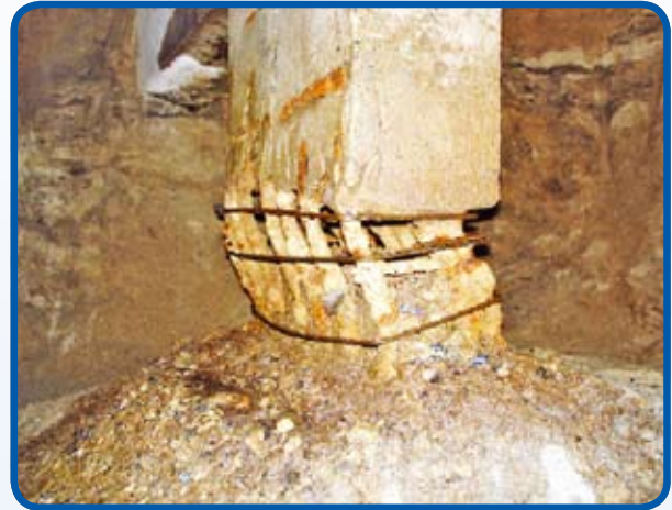
Pilar comprometido em seu desempenho estrutural pela RAA
