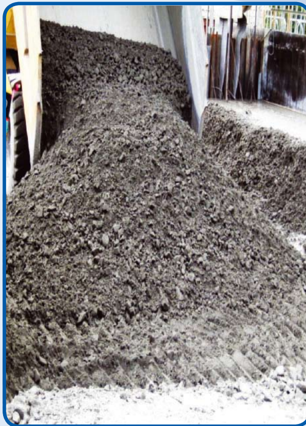
Descarregamento do Concreto Compactado com Rolo (CCR) no local da concretagem
