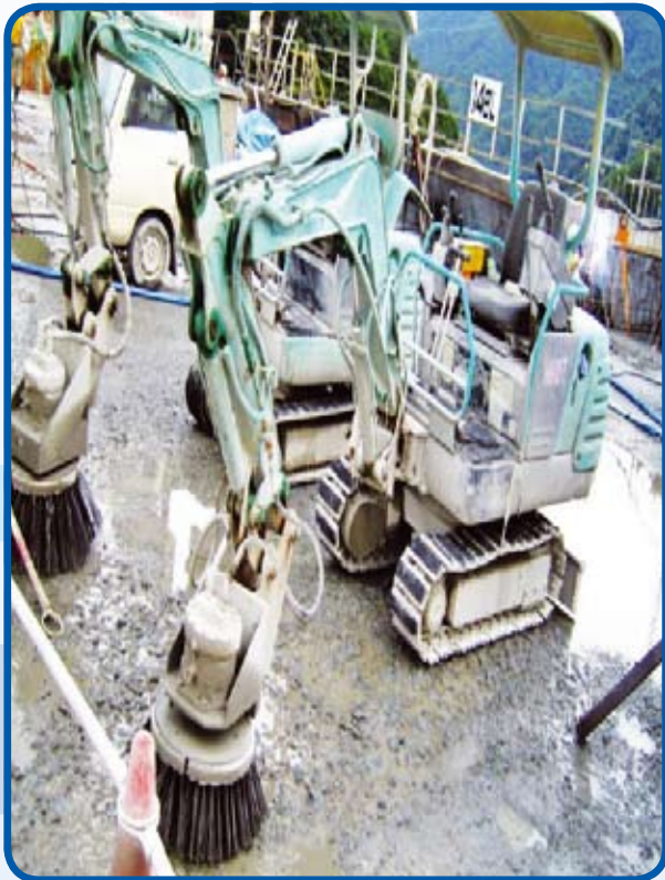
Corte verde feito por sweepers na camada de CCR
