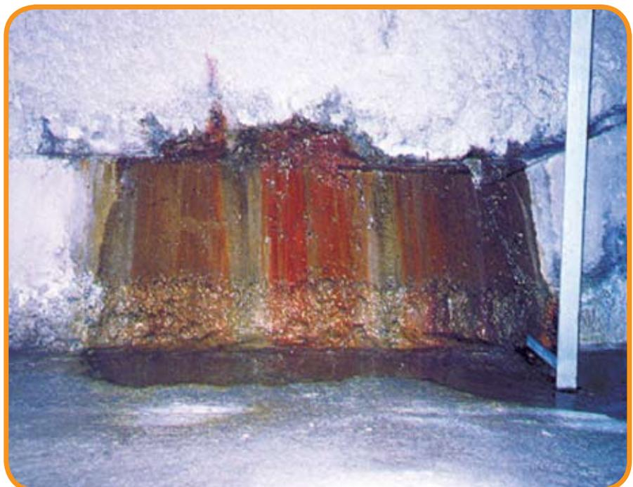
Figura 2 – Infiltrações na junta de concretagem na interface de concreto projetado e o moldado “in loco”
