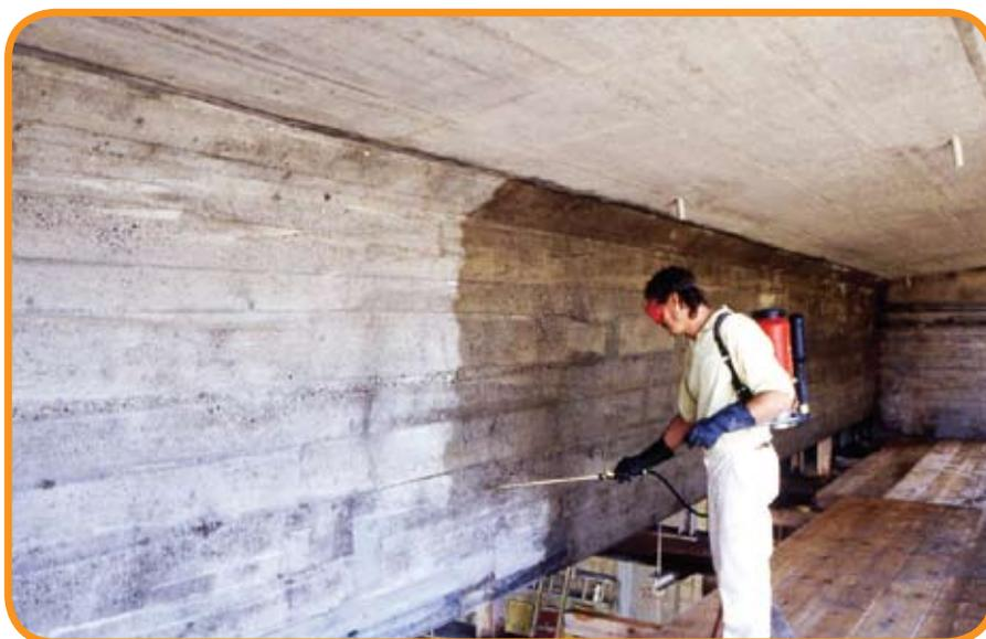
Figura 1 – Aplicação de inibidor de corrosão misto de impregnação por aspersão no concreto
