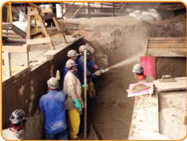
Foto 2 – Projecção de concreto nas paredes internas do canal
