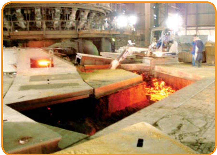
Foto 1 – Demolição do revestimento do canal em tijolos refratários
