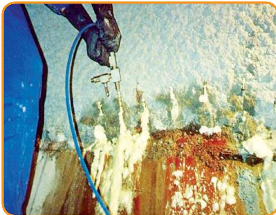
**Figura 3** – Tamponamento provisório da infiltração com espuma hidroativada expansiva
