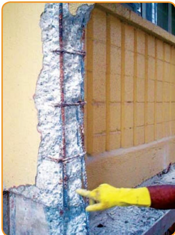
Figura 11 – Preparo da superfície do concreto
