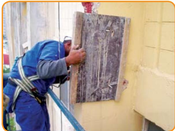
Figura 14 – Foto extraída da obra ilustrando a reconstituição do concreto com “grouth” lançado pelo “cachimbo” fixado posteriormente
