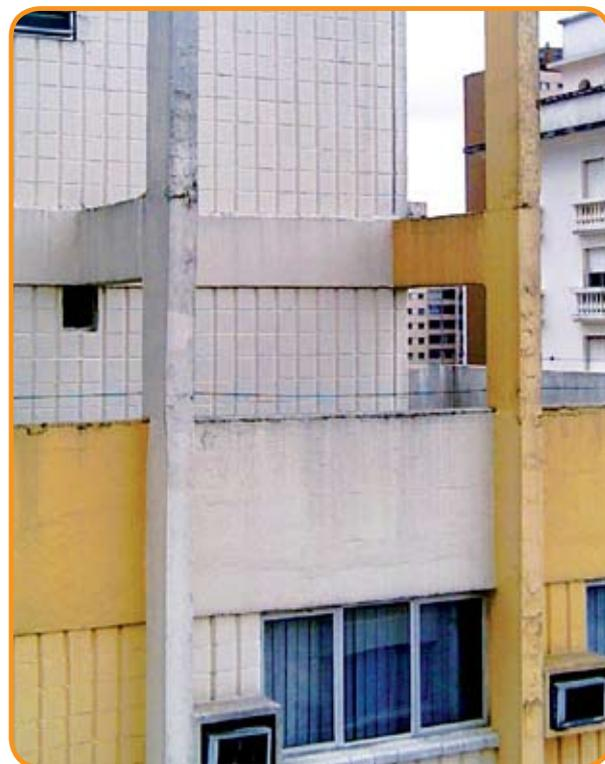
**Figura 6** – Lascamento da camada de cobrimento em face à expansão do aço pela sua corrosão
