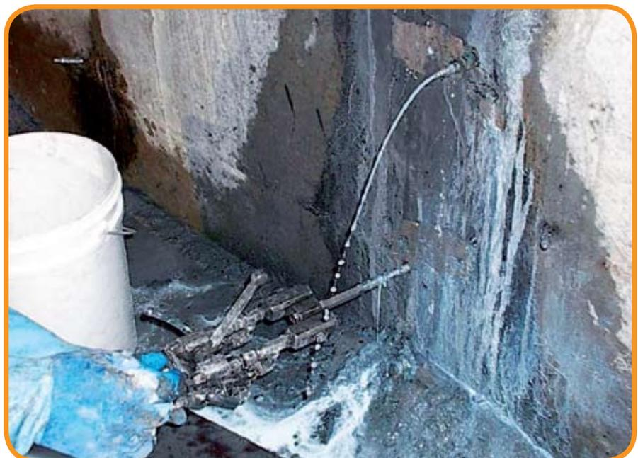
Figura 6 – Injeção de resina hidroestruturada de gel acrílico polimérico
