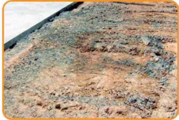
observada na Figura 5, levando o subleito a valores elevados de umidade e, conseqüentemente, à perda da capacidade de suporte.
