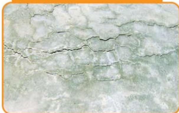
Figura 3 – Delaminação do piso
