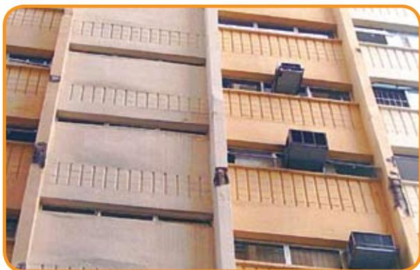
**Figura 5** – Corrosão do aço com o deslocamento da camada de cobrimento de concreto dos pilares
