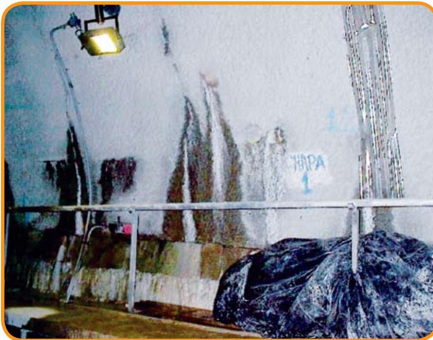
Figura 1 – Infiltrações através de fissuras no revestimento secundário de concreto projetado.
