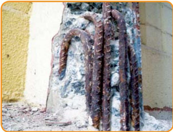
Figura 7 – Detalhe armadura de encontro
