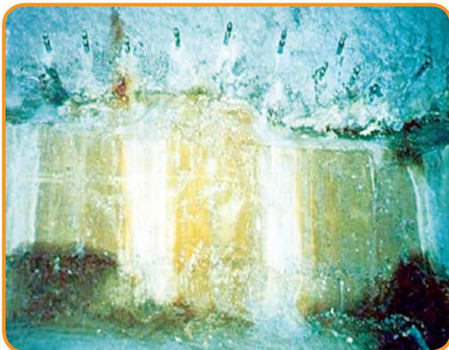
**Figura 4** – Selamento definitivo da infiltração com resina elastomérica de poliuretano ("gel de poliuretano")
