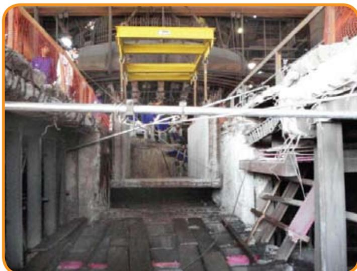
Foto 3 – Instalação dos elementos pré-moldados com a utilização de ponte rolante
