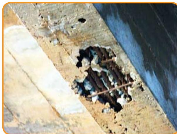
Foto 2 – Exemplo de exposição e corrosão de armaduras na face inferior da viga do tabuleiro
