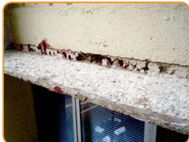
Figura 10 – Detalhe “ninhos” de concretagem
