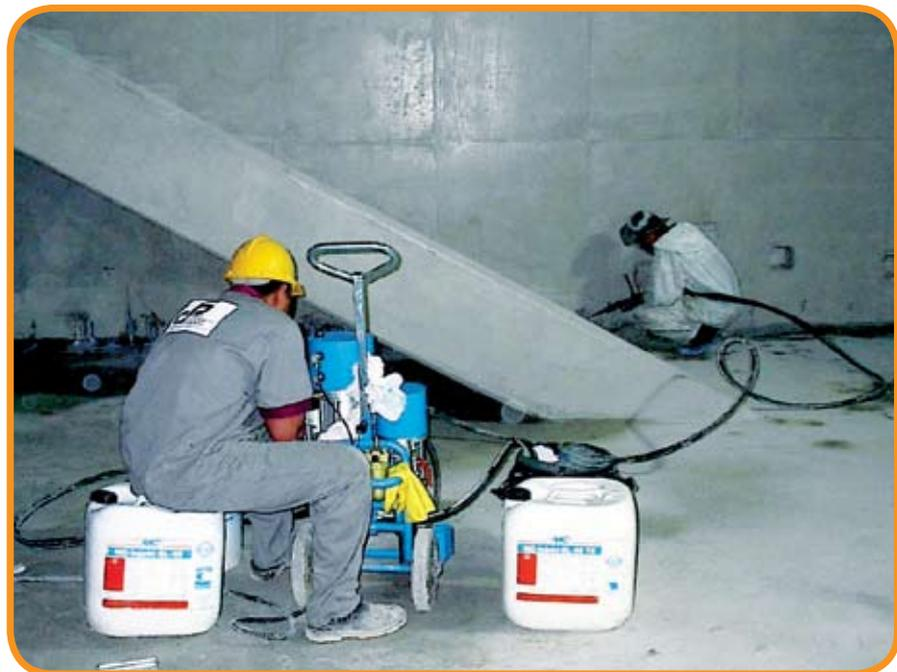
Figura 7 – Bomba de injeção bicomponente utilizada na injeção de gel acrílico polimérico
