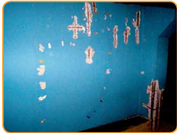
Figura 9 – Falta de cobrimento de concreto
