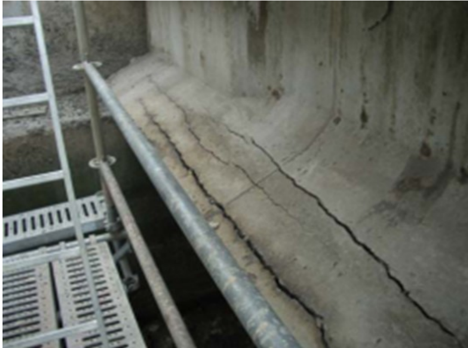
REPARACIÓN DE SECAO
