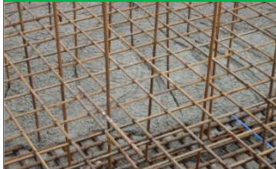
LANÇAMENTO DO CONCRETO AUTOADENSÁVEL
