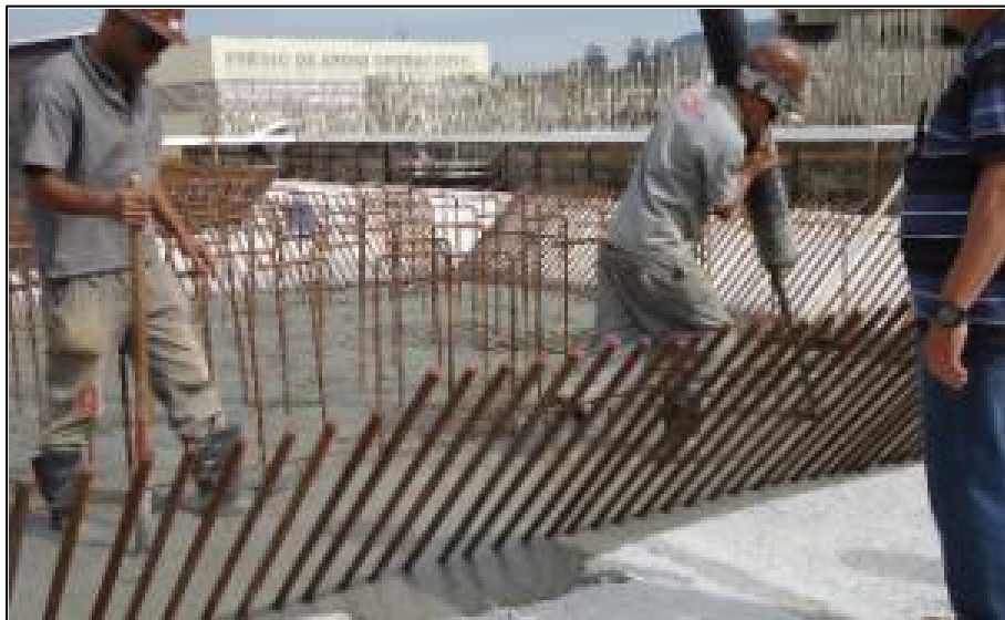
LANÇAMENTO DO CONCRETO AUTOADENSÁVEL
