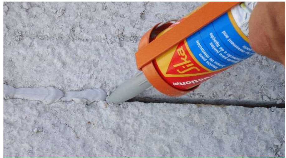
PREENCHIMENTO DAS JUNTAS SERRADAS COM CORDÃO DE SISAL E MASTIQUE DE POLIURETANO
