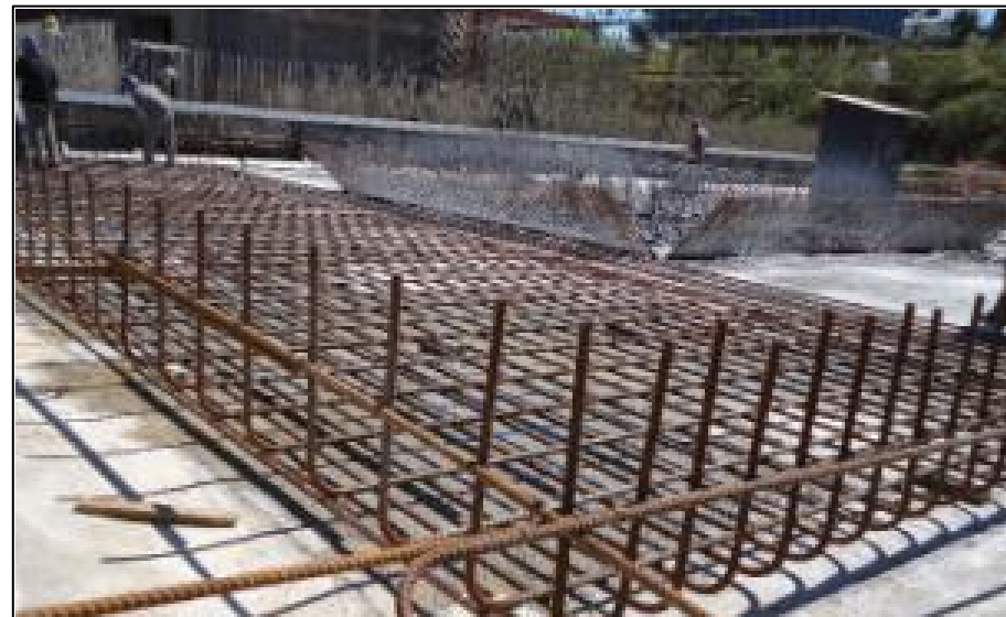
EXECUÇÃO DA ARMADURAS DA LAJE DE FUNDAÇÃO
