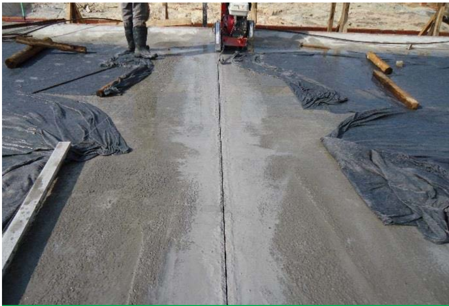
EXECUÇÃO DAS JUNTAS SERRADAS
