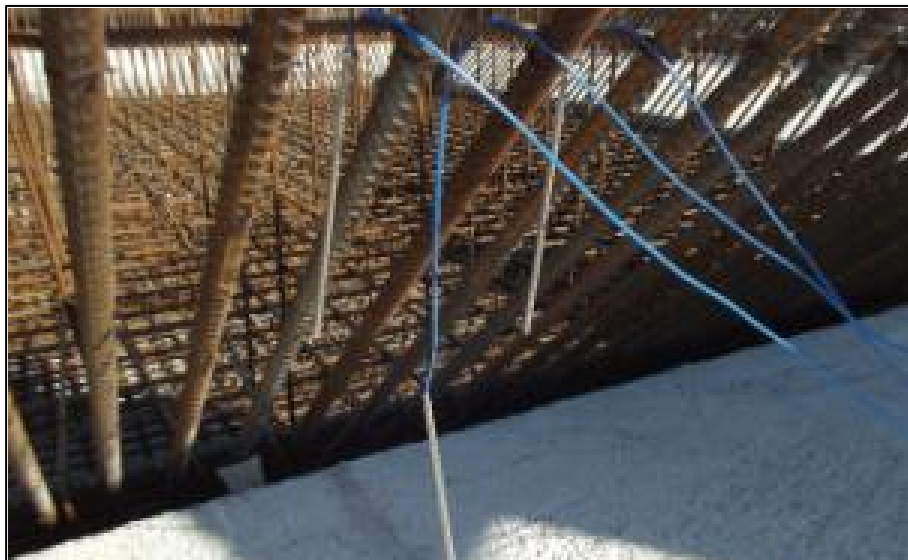
COLOCAÇÃO DOS TERMOPARES NAS CHAVETAS
