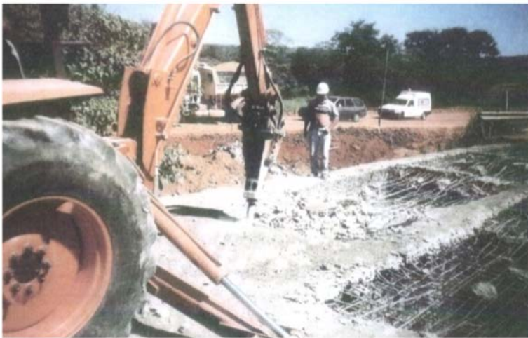
Substituição da laje
