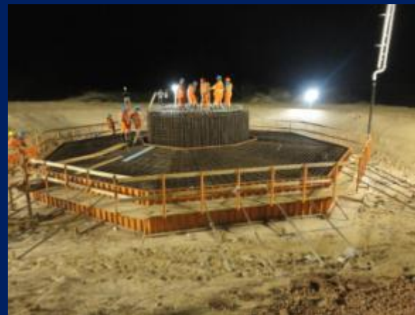
Bloco de fundação – União dos Ventos - RN; v \sim 260\text{m}^3 (arquivo Deseq, 2011)
