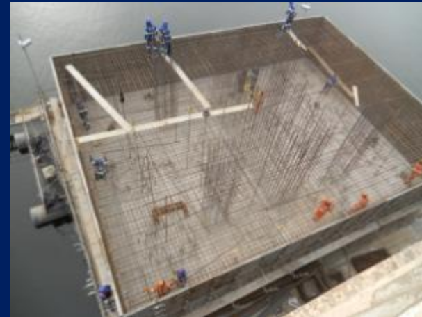
Bloco de fundação - SP; v \sim 670\text{m}^3 (arquivo Deseq, 2013)
