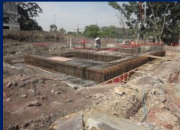
Bloco de fundação em São Paulo; v ~390m 3 (arquivo Deseq, 2011)
