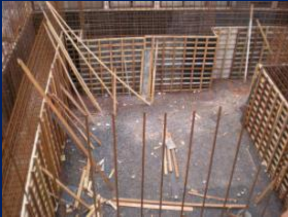
Paredes espessas – Bunker; largura de ~1,5m (arquivo Deseq, 2008)
