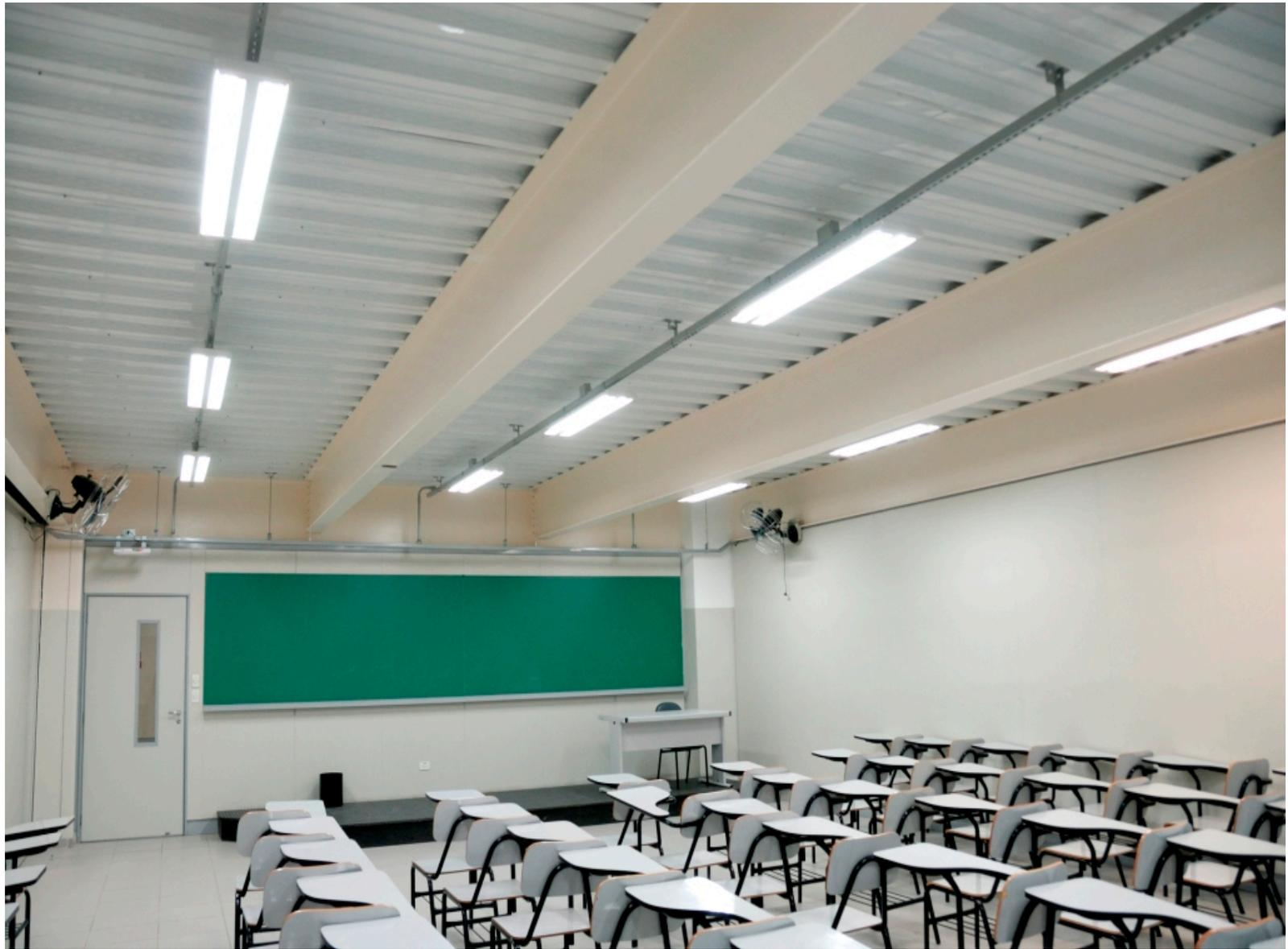
Viga sem conectores e sem ação mista
