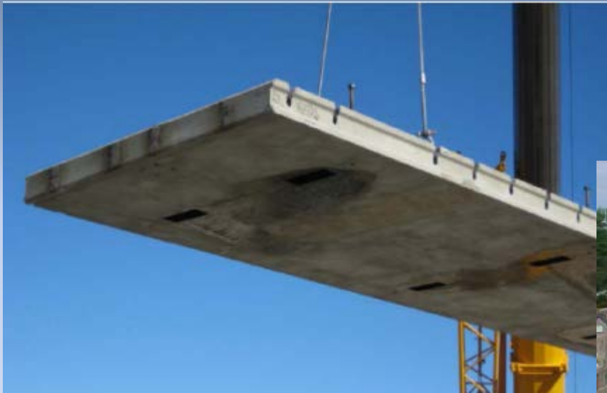
Lajes pré-fabricadas de concreto armado ou protendido
