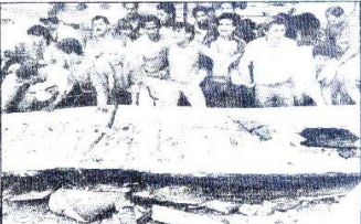
Quatro toneladas de concreto desabam matando e ferindo
