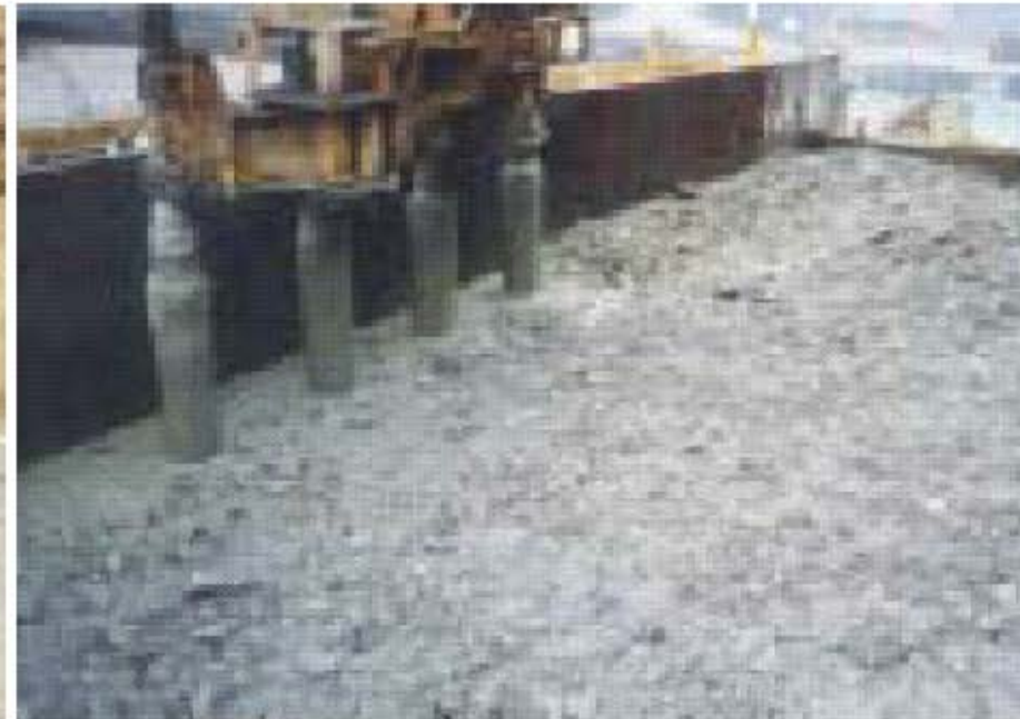
Figura 31 – Processos de adensamento do GERCC em Tannur e Jiangya Dam. Fonte: International Water Power & Dam Construction.
