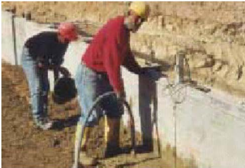
Figura 31 – Processos de adensamento do GERCC em Tannur e Jiangya Dam. Fonte: International Water Power & Dam Construction.
