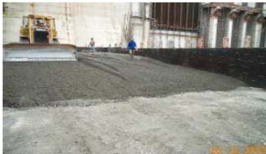
Fotografia 1- Lançamento de CCR em Rampa
