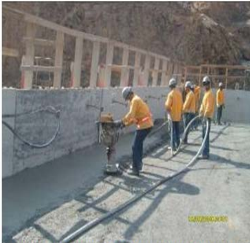
Figuras 42 e 43 – Compactação do contato CCV/CCR e lançamento de CCV no paramento de montante, respectivamente
