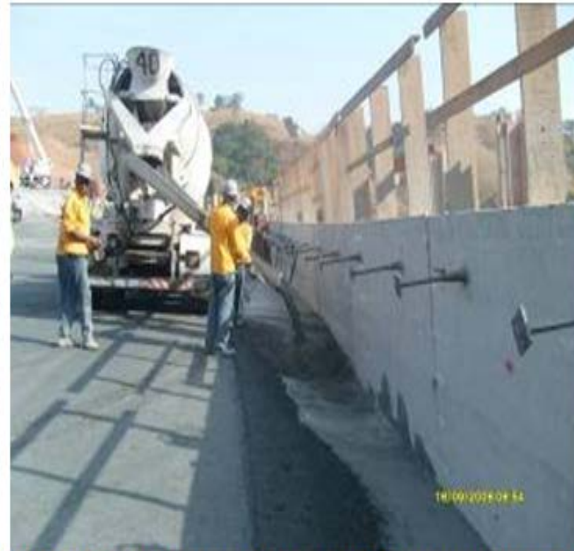
Figuras 42 e 43 – Compactação do contato CCV/CCR e lançamento de CCV no paramento de montante, respectivamente
