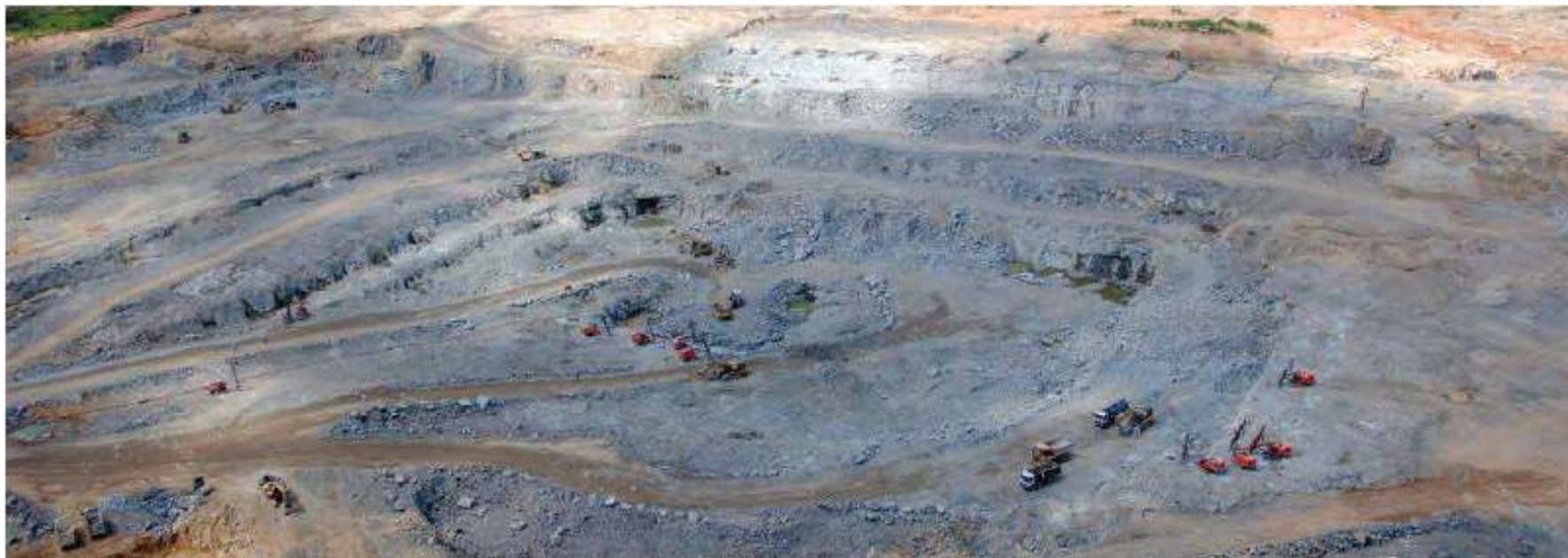
Sítio Belo Monte Circuito de Geração – Escavação em Rocha
