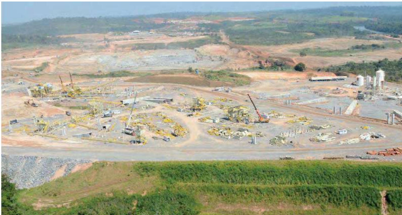
Sítio Belo Monte Central de Concreto e Britagem
