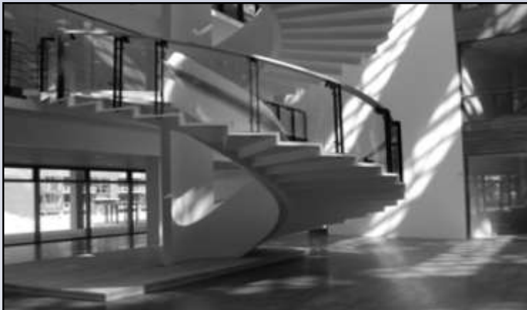
Escalera con láminas de 30 mm de espesor.
