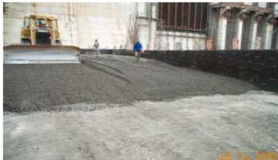
Fotografia 1- Lançamento de CCR em Rampa
