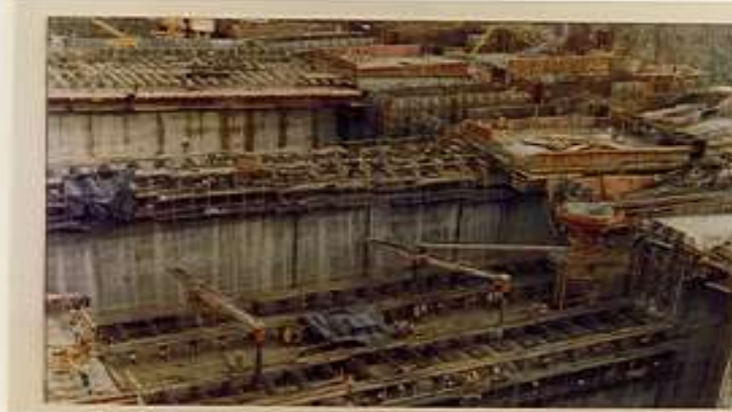
Figura 34 - Uso de esteiras para concretagens com formas deslizantes.
