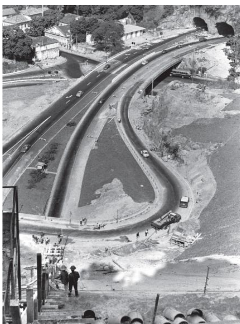
Figura 3- Túnel Rebouças na época da inauguração ( Carvalho 2006)
