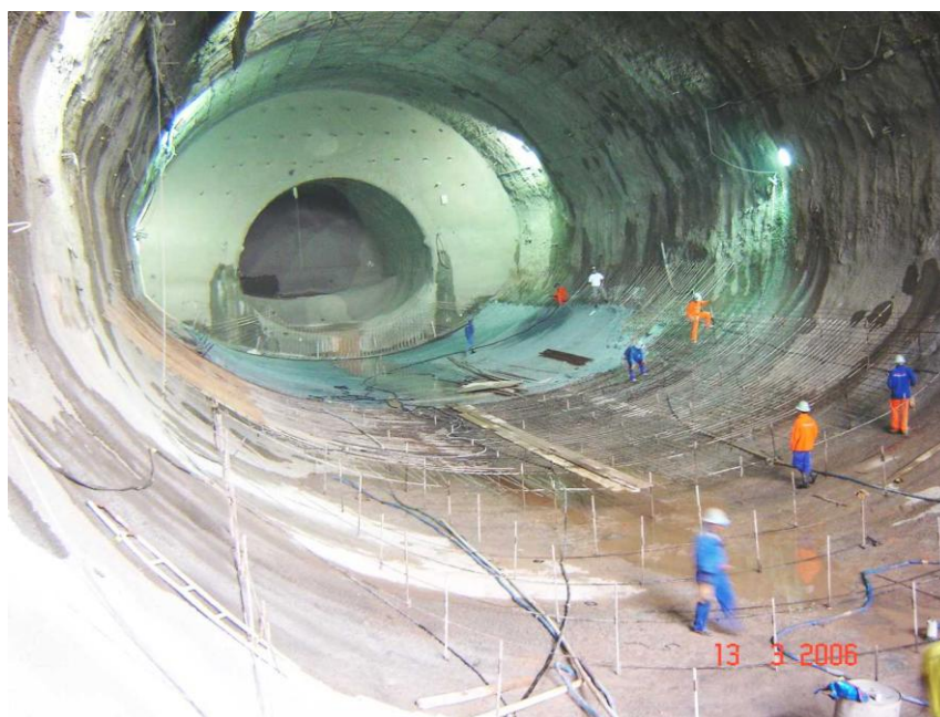
Figura 7- Estação Alto do Ipiranga, totalmente escavada, com revestimento primário em concreto projetado.
