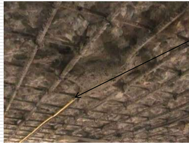
Instalação do eléctrodo de referência
