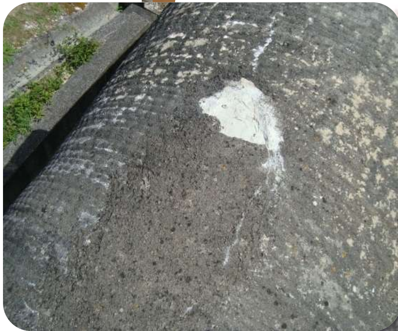
Fissura longitudinal com presença de água no adutor centrífugo Fissura com presença de água no adutor centrífugo Deficiente técnica de execução / instalação
