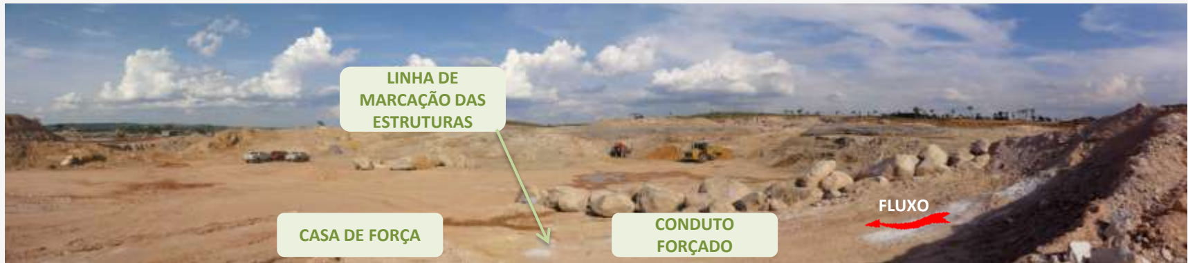
SÍTIO BELO MONTE – Término do Conduto Forçado
