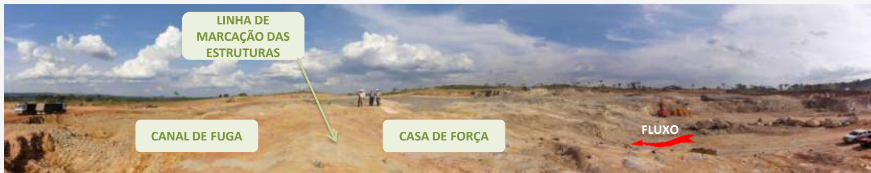
SÍTIO BELO MONTE – Término da Casa de Força, início do Canal de Fuga
