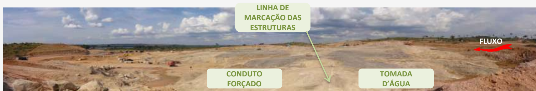
SÍTIO BELO MONTE – Conduto Forçado e Tomada D'água
