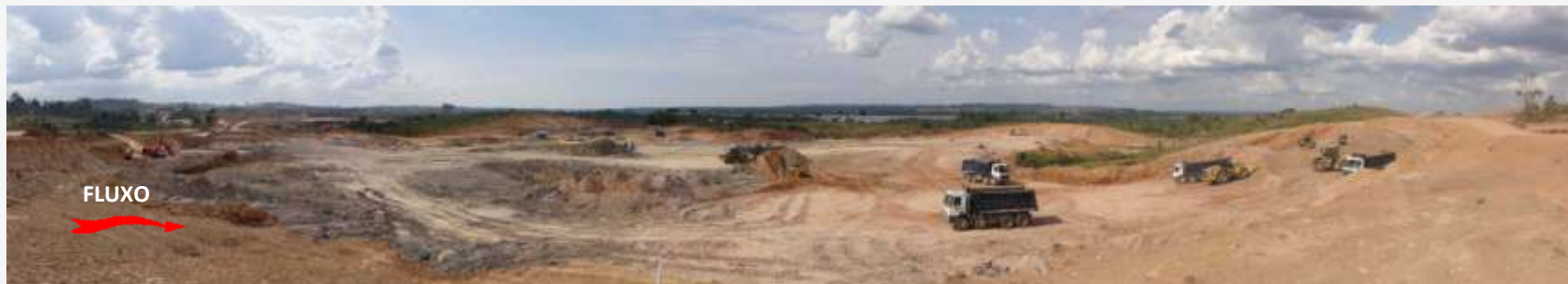
SÍTIO BELO MONTE - Vista geral das escavações
