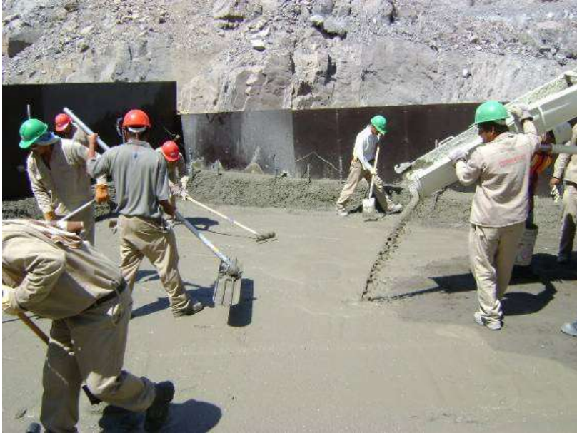
Colocación de mortero de liga.
