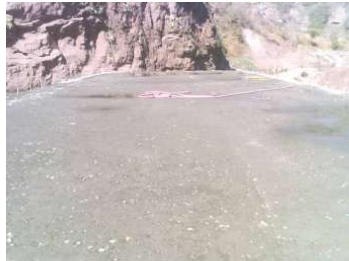
Capa terminada, se cura todo el día para evitar grietas.
