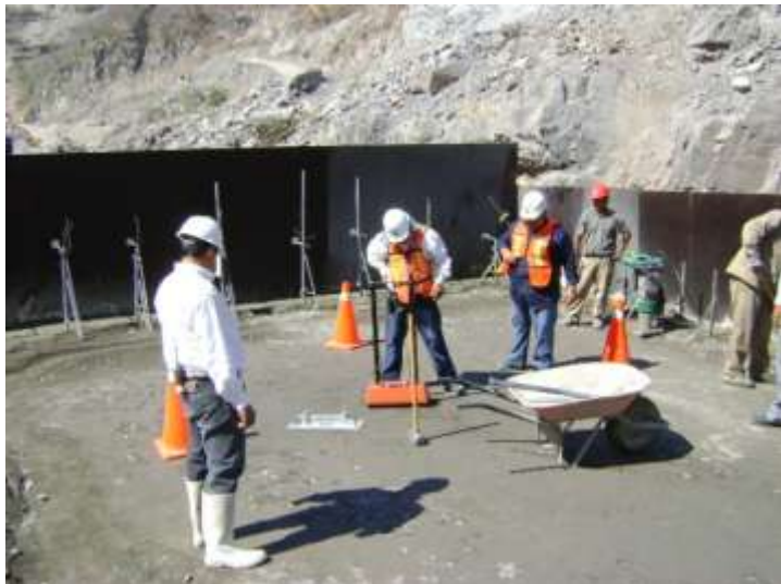
Determinación de compactación con densímetro nuclear.
