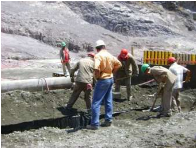
Colocación de Junta fría.
