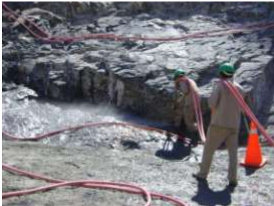
Lavado de roca para colocar concreto convencional y CCR.
