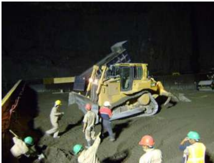
Acarreo y colocación de CCR
