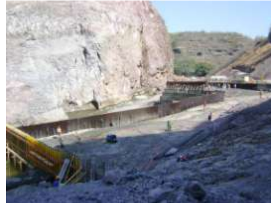
Colocación de cimbra para habilitar el área.
