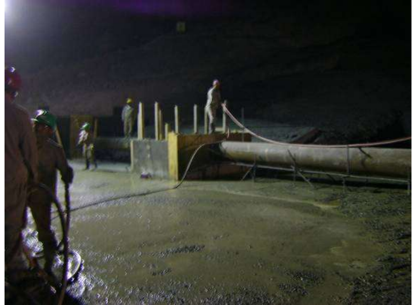
Colocación de mortero de liga.
