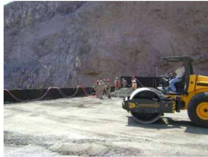
Compactación de Plataforma.
