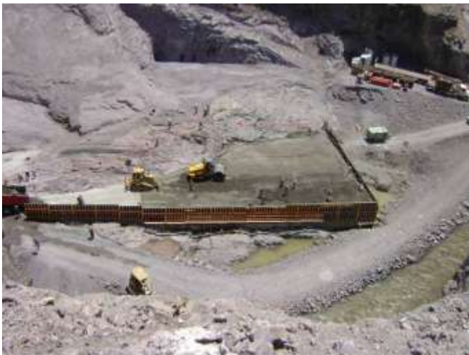
Vista panorámica, de la compactación.
