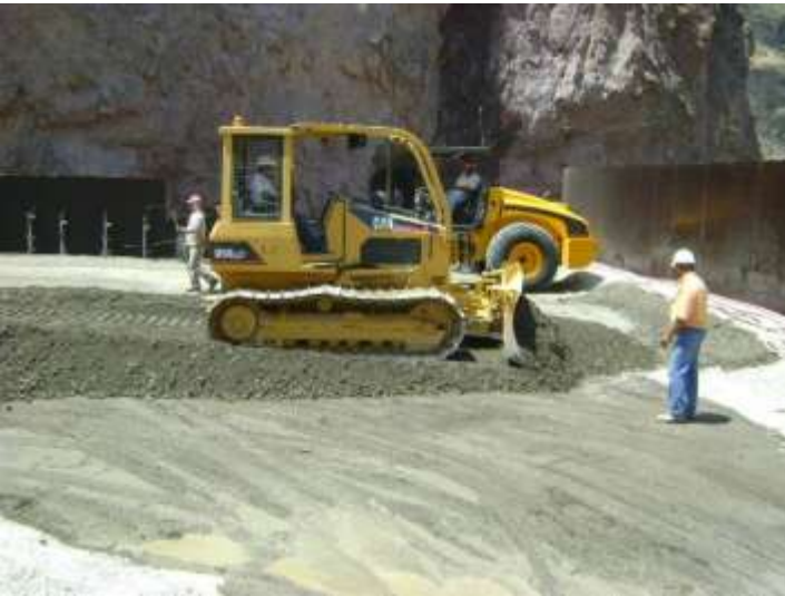
Acarreo y colocación de CCR
