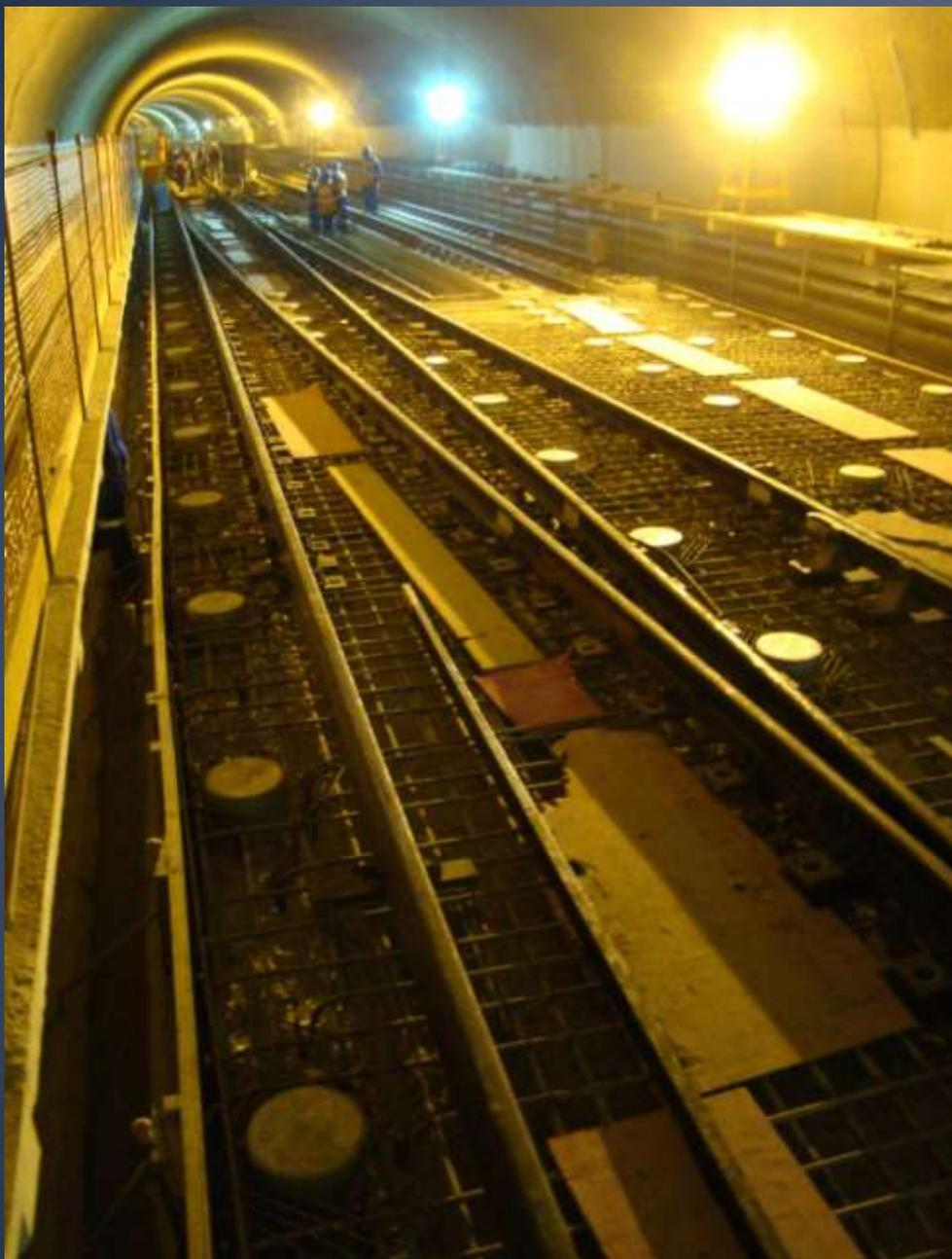
Para correta locação dos chumbadores das fixações, o AMV é montado sobre a laje antes da concretagem
