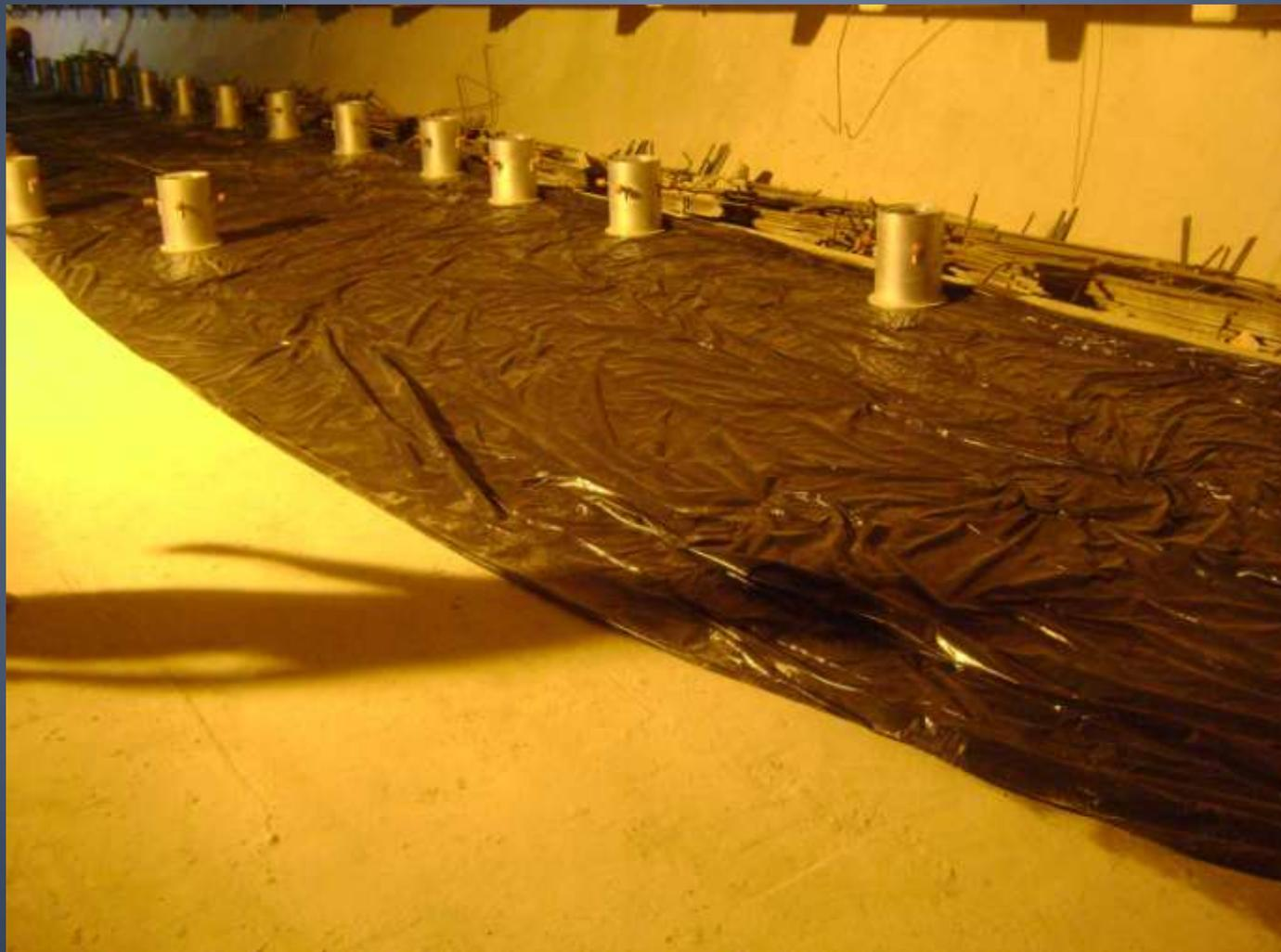
Detalhe do cilindro metálico no qual a mola é inserida
