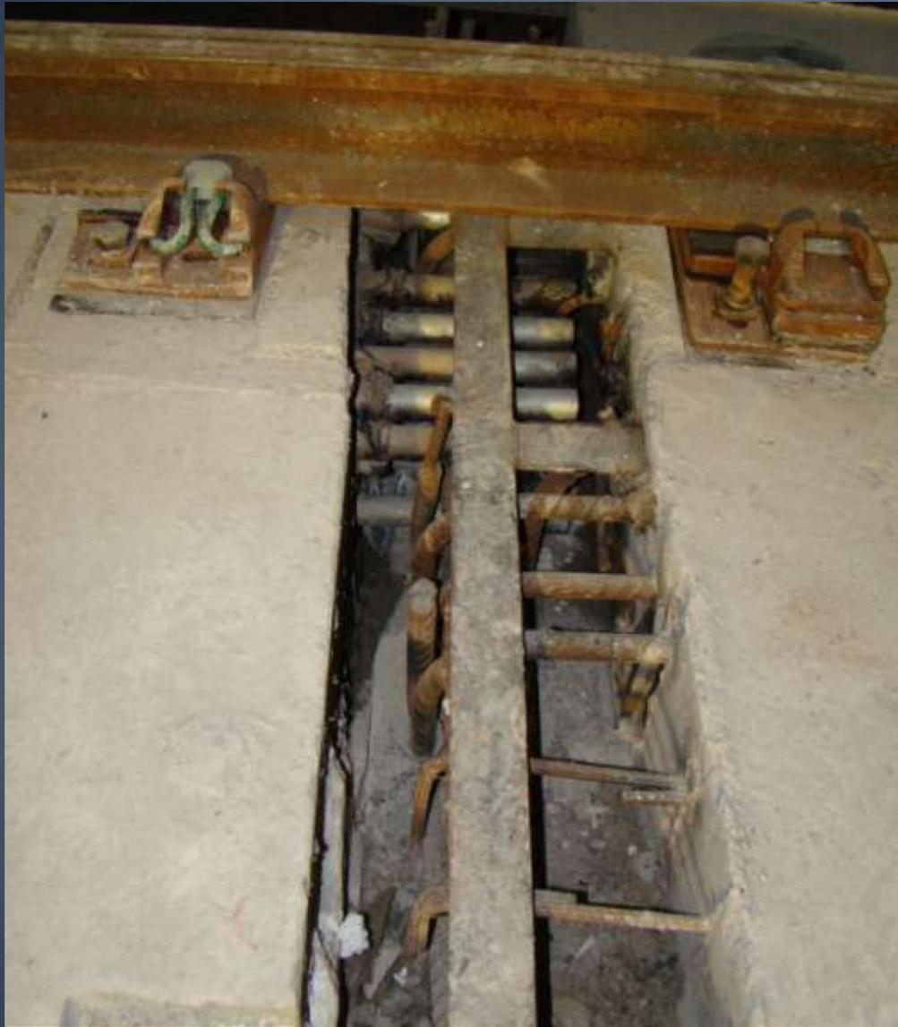
Laje concretada – acesso às molas pelas tampas dos cilindros na face superior
