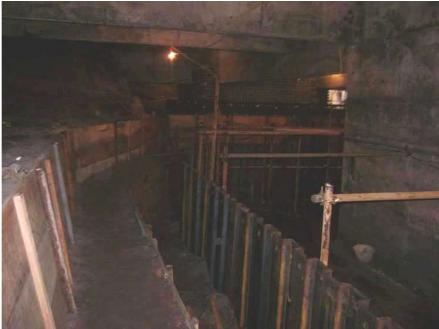
Detalhe do escoramento
