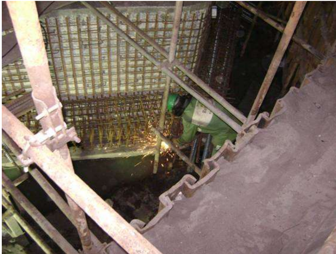
Poço do elevador
