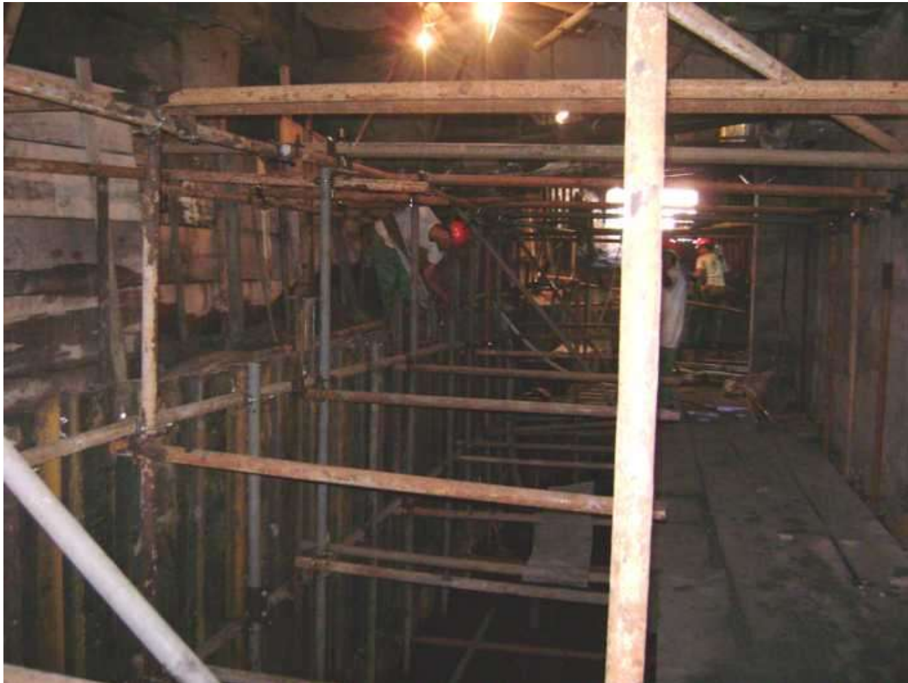
Detalhe do escoramento
