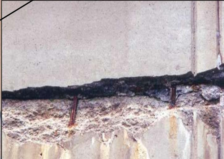
**Concreto danificado próximo à junta
