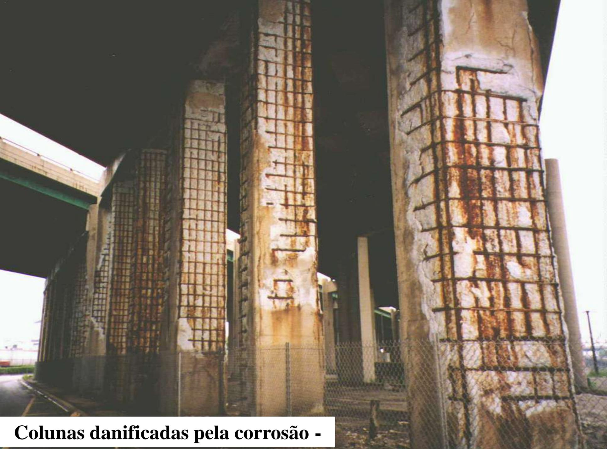
**Colunas danificadas pela corrosão -**
