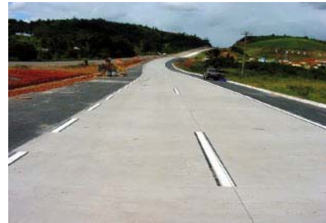
Rodovia BR 232 Recife-Caruaru - PE
