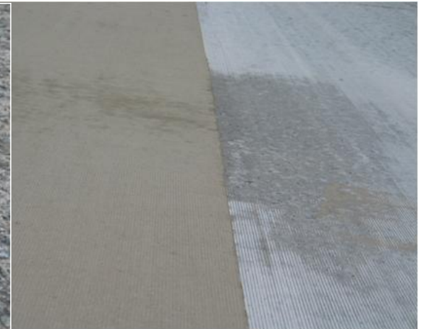
Após / Antes (concreto)
