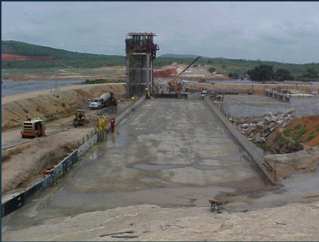
Barragem de CCR em construção - vista da praça de trabalho
