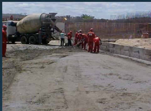
Aplicação de concreto convencional no paramento de jusante
