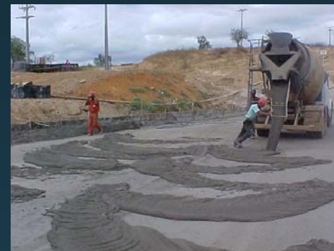
Aplicação de argamassa na ligação entre camadas de CCR
