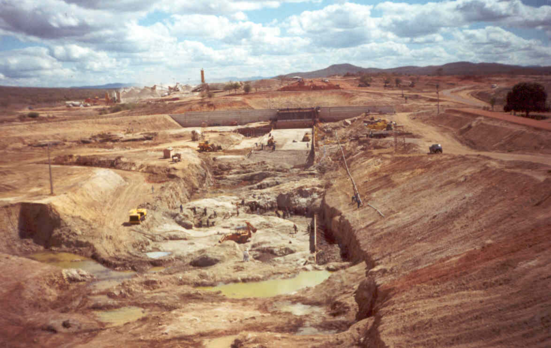
Vista panorâmica da obra. Central de produção de CCR, Limpeza de fundação, Execução de CCR, Execução das Galerias; Execução de Aterro.
