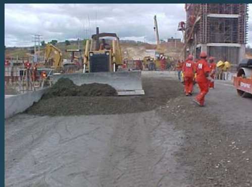
Espalhamento de CCR com trator de esteiras
