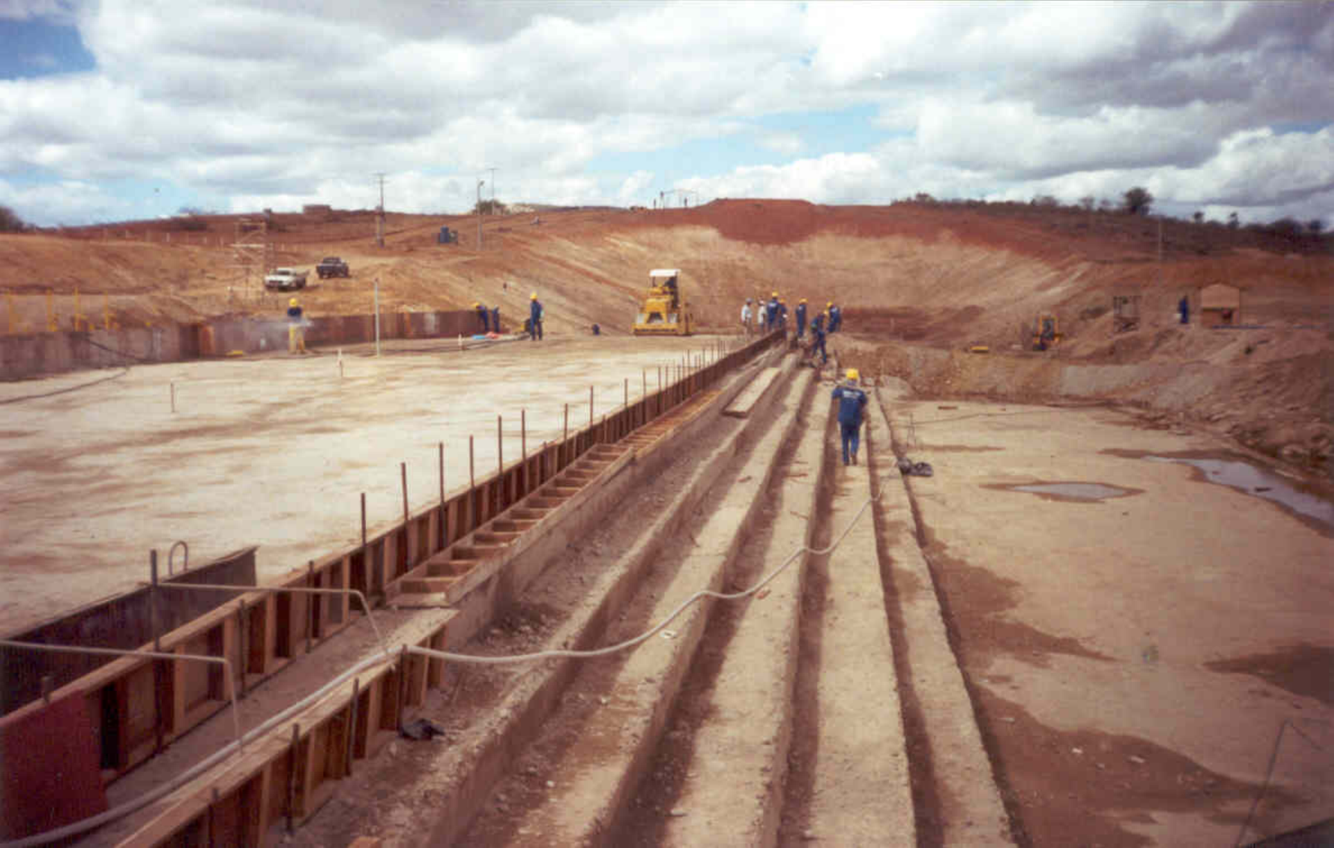
PONTO NOVO - Detalhe do maciço de CCR em execução.
