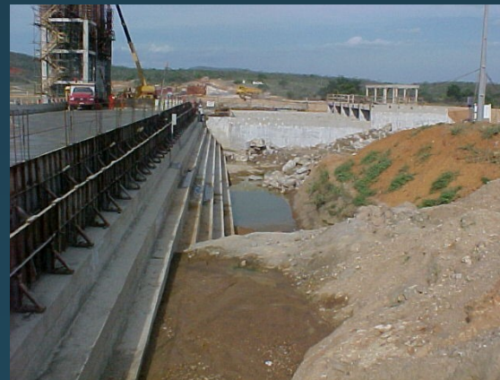
Barragem de CCR em construção vista do lado de jusante
