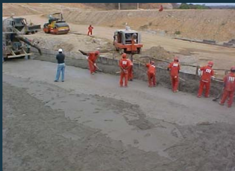
Lançamento de concreto convencional na face de montante
