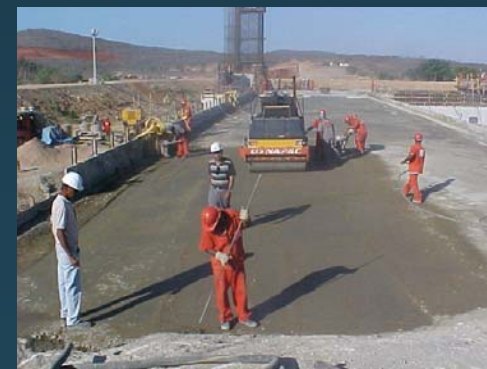
Vista da etapa de compactação
