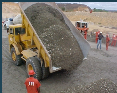
Lançamento de CCR com caminhão fora-de-estrada
