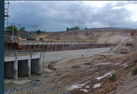
Barragem de CCR em construção da forma do lado do reservatório (montante)
