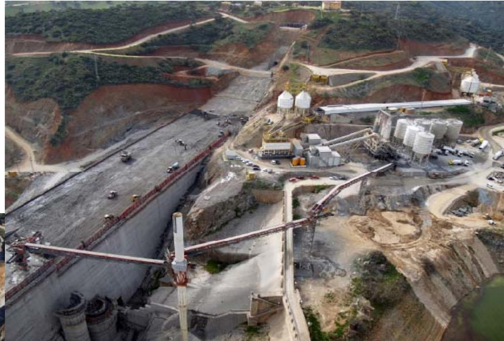
**La presa de la Breña II: 119 m de altura y un volumen 1.400.000 m<sup>3</sup> de hormigón HCR. Se está construyendo a unos 100 m aguas abajo de la actual presa de la Breña I. Bloques (26) de entre 15-30 m.**
