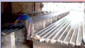
Controle tecnológico na produção de trilhos de lajes pré-fabricadas
