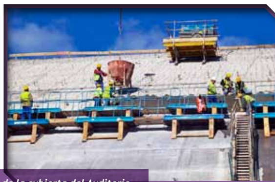
Distintas etapas de la ejecución de la cubierta del Auditorio
