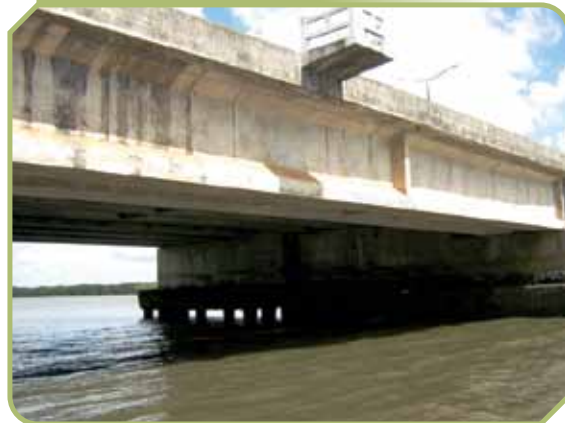
Figura 1 - Vista lateral da Ponte de Igapó, com vigas protendidas sem nenhum indício de corrosão das armaduras
