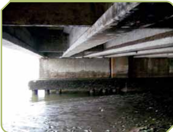
Figura 8 – Vista das vigas protendidas sem nenhum indício de corrosão das armaduras
