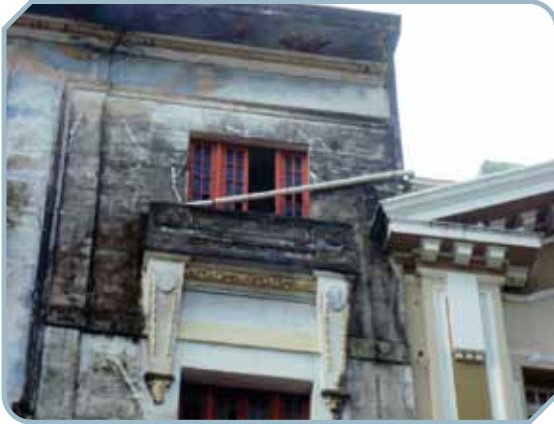
Foto 7 – Tubulação de queda d'águas pluviais sobre a Marquise M3
