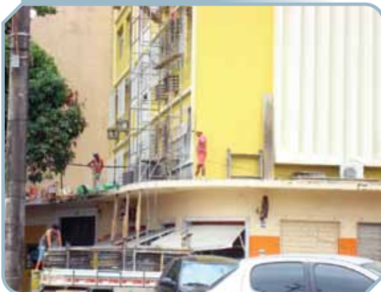
Foto 2 – Detalhe da reforma com homens, andaimes e materiais de construção sobre a M2 no centro do Recife
