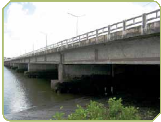
Figura 9 – Vista lateral da Ponte de Igapó com vigas protendidas sem nenhum indício de corrosão das armaduras
