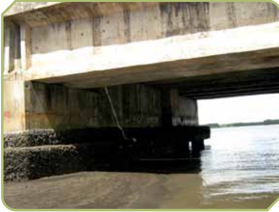
Figura 2 – Vista de um pilar-parede da Ponte de Igapó
