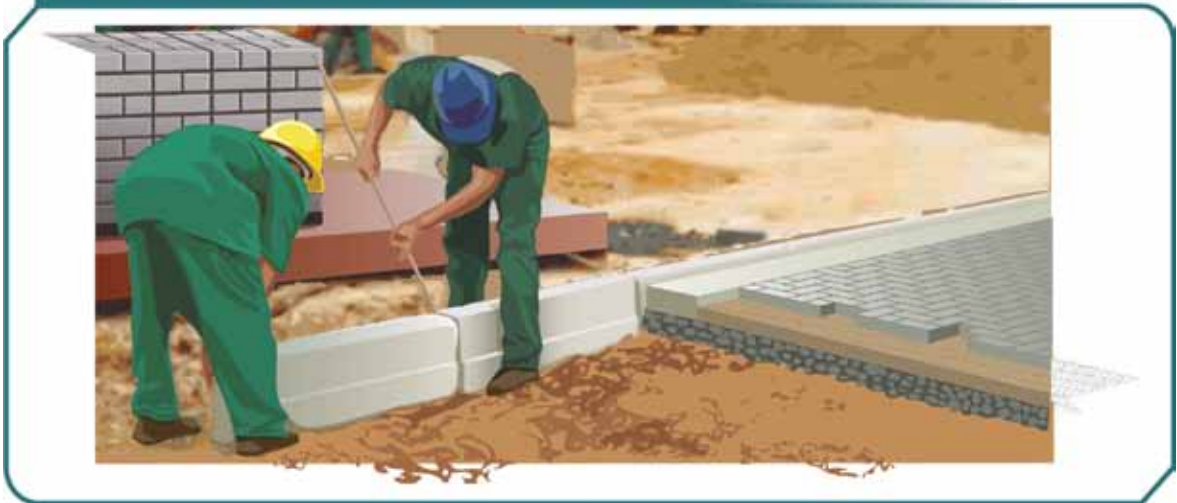
Figura 4 - Guia utilizada como contenção de pavimento intertravado
