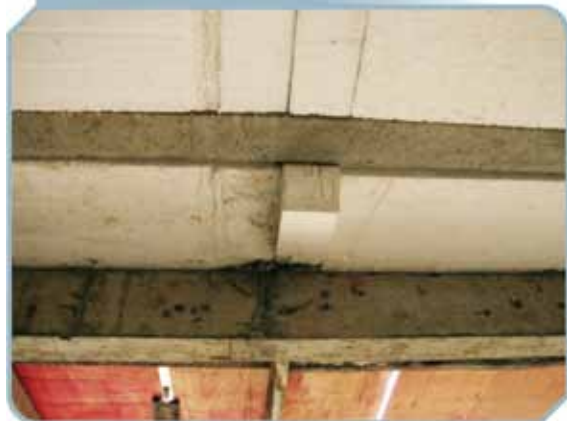
Figura 3 - Descida de bloco de EPS na concretagem
