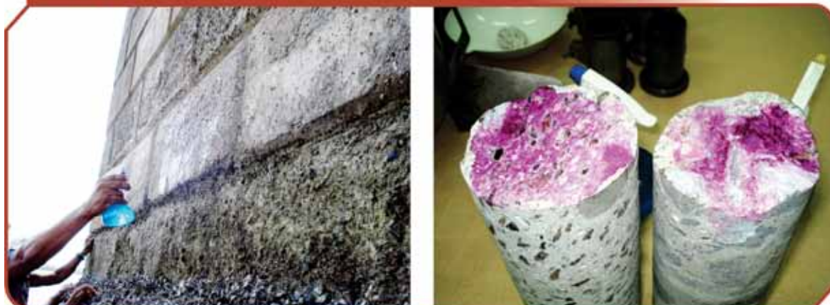
Figuras 5 e 6 - Aspersão de Fenolftaleína na superfície do bloco e medição da profundidade de carbonatação (de 1 a 30cm no concreto)
