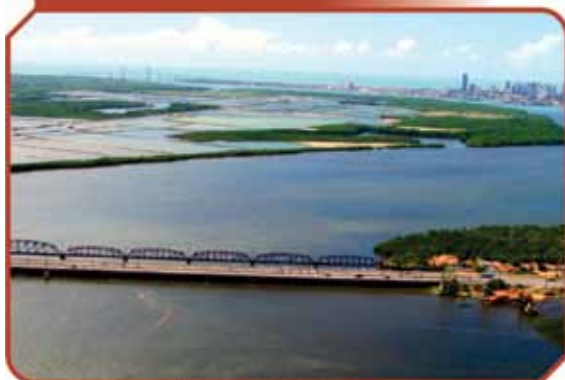
Figura 1 - Vista aérea da ponte em treliça metálica. Foto: Esdras Rebouças Nobre www.fotosdenatal.com.br
