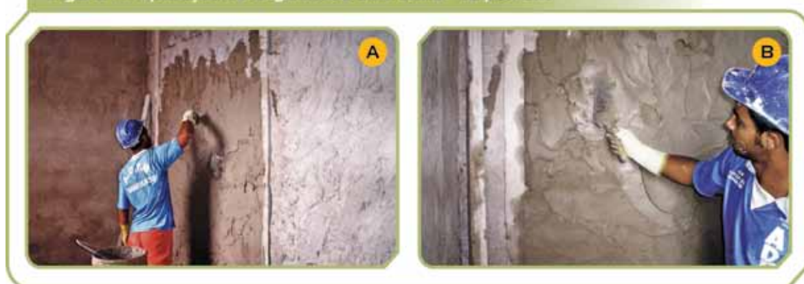
Figura 1 – Aplicação da argamassa com colher de pedreiro
