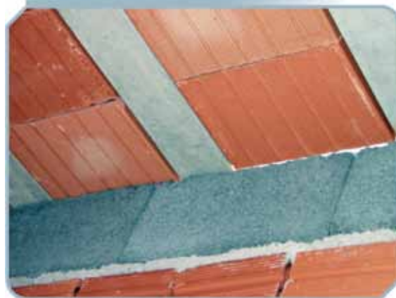
Figura 6 – Vigotas apoiadas sobre blocos de concreto
