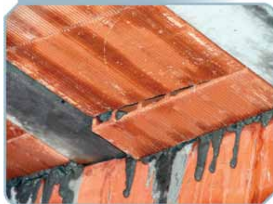
Figura 2 – Descida de bloco cerâmico durante a concretagem
