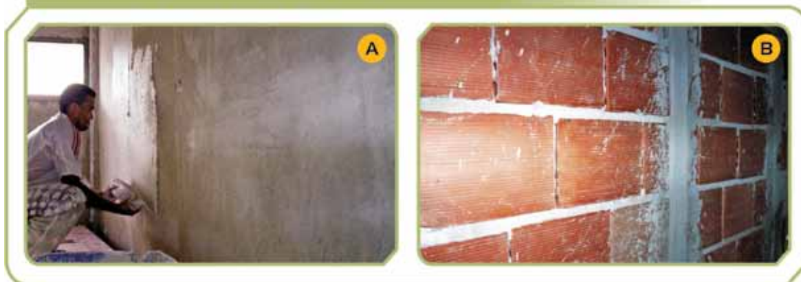
Figura 2 – a) Aplicação do gesso fino. b) Base preparada para aplicação do gesso direto na parede com espessura de 20 mm
