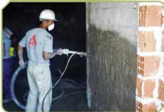
Figura 4 – Lançamento por equipamento de projeção mecanizado
