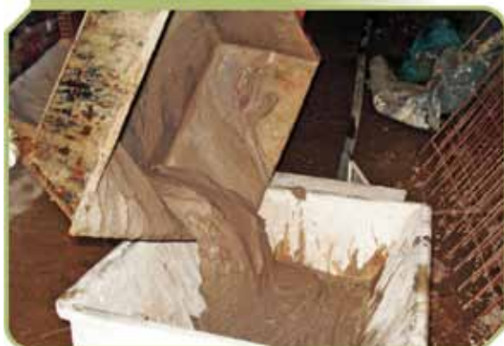
Figura 3 – Argamassa depositada no recipiente do equipamento de projeção
