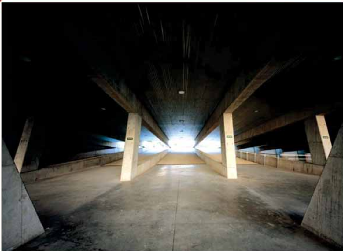
Figura 10 - Vista de pórticos radiales y parte inferior de la cubierta prefabricada
