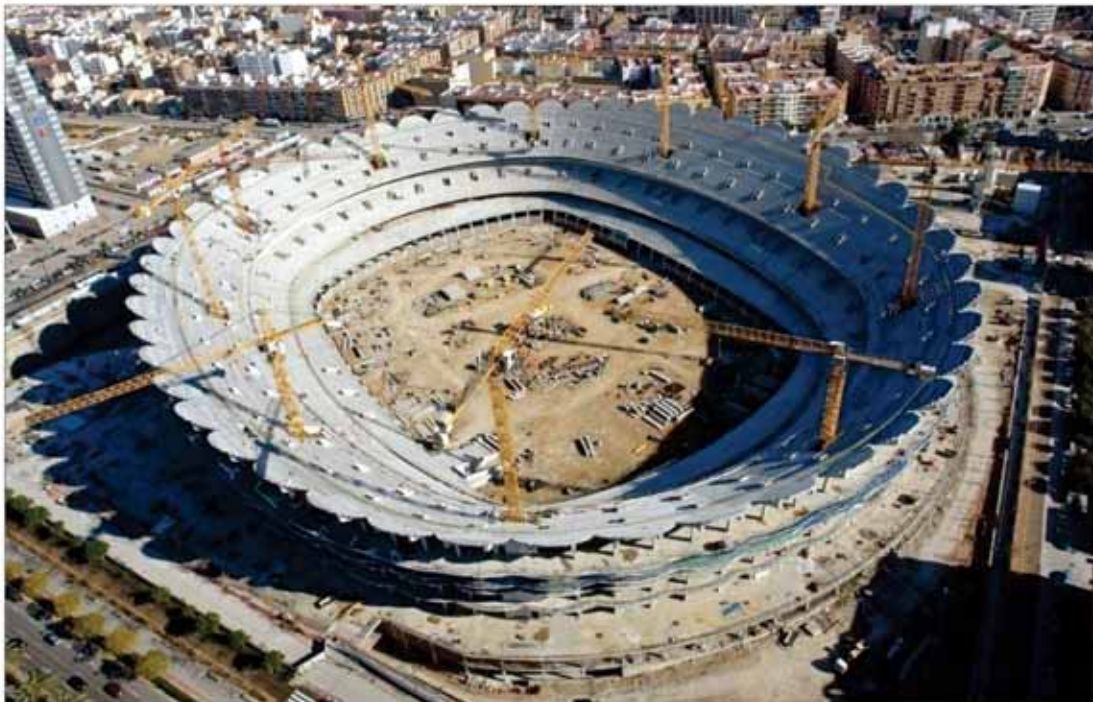
Figura 2 - Grúas torre empleadas en la ejecución de la estructura de hormigón del Nuevo Mestalla
