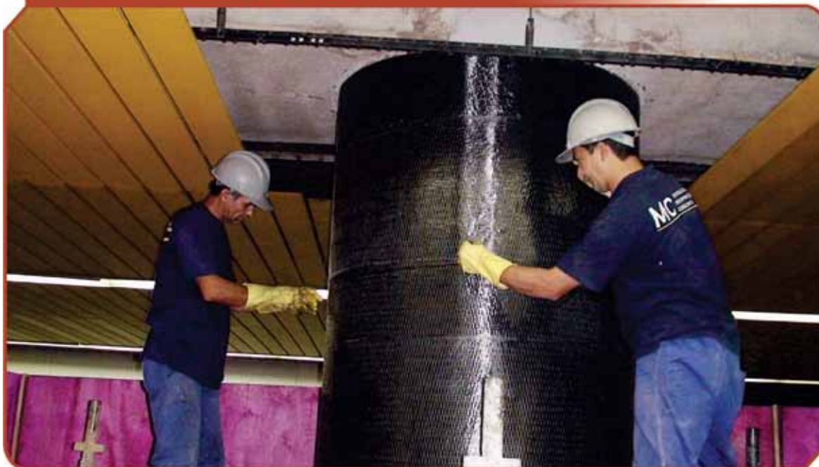
Foto 1 – Confinamento total do pilar
