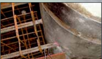
Reforço para transferência de cargas
