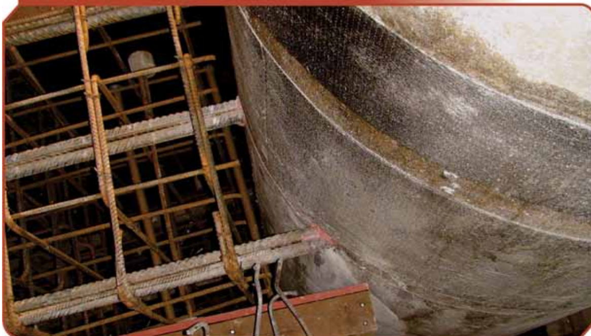
Foto 2 – Reforço de pilar com ancoragem de armaduras para construções novas
