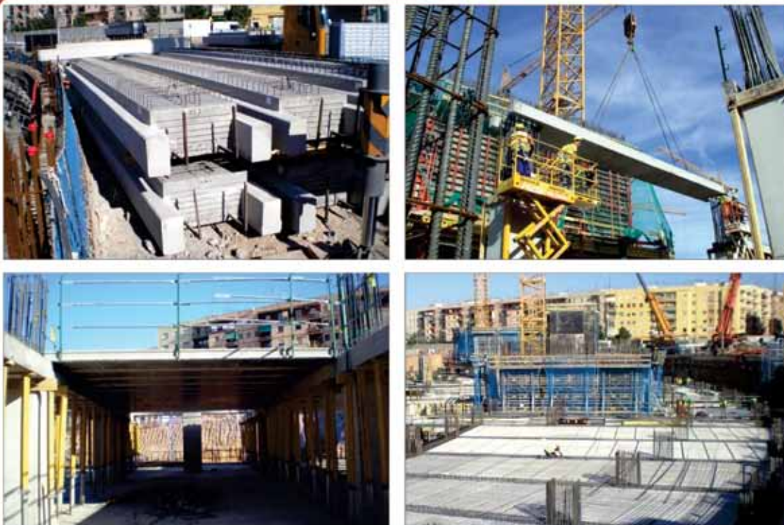
Figura 4 - Acopio, colocación de viga prefabricada, de placas alveolares, y placas antes de hormigonar la losa de compresión
