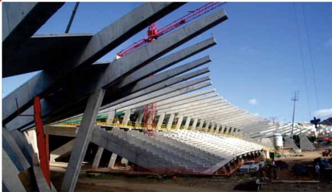
Figura 8 - Superficie alabeada definida por los pórticos del graderío, cubierta con elementos prefabricados
