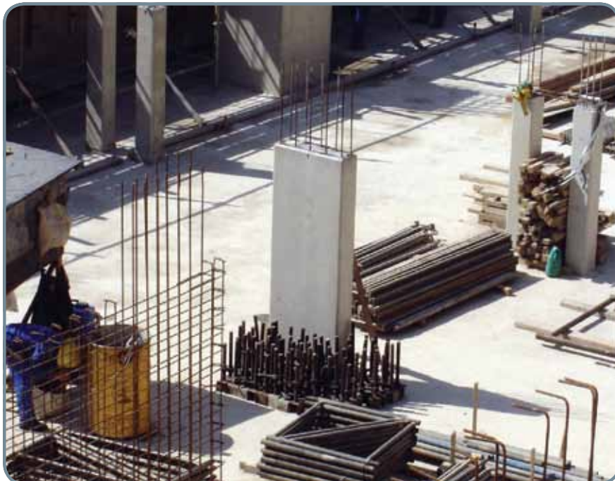
Figura 2 - Resultado do adensamento efetuado de maneira correta e com o devido cuidado
