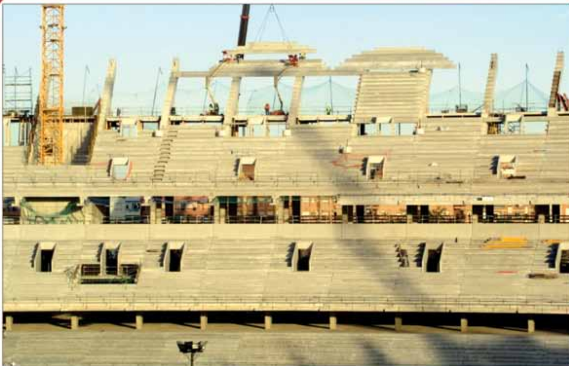
Figura 7 - Colocación de pétalos prefabricados en parte superior de gradas
