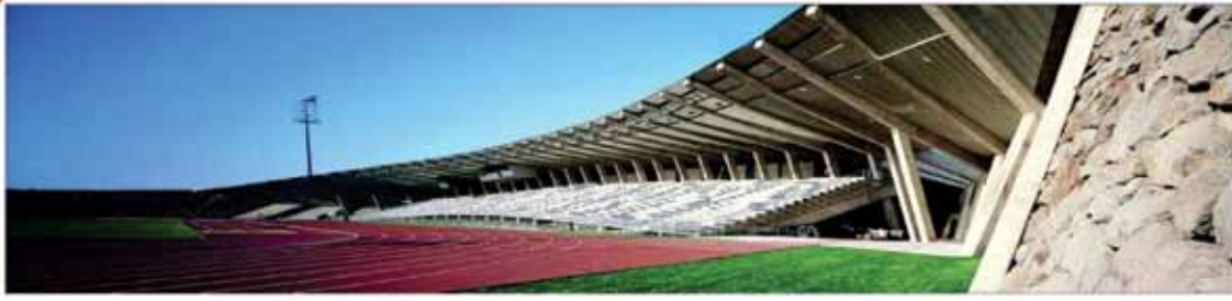
Figura 9 - Vista del estadio terminado, con el graderio y los elementos de cubierta prefabricados
