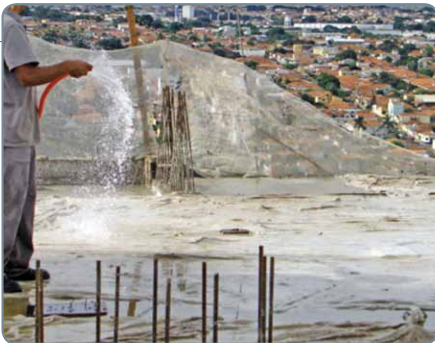
Figura 4 - Cura a partir da molhagem da superfície, com cobrimento de tecidos para retenção da água
