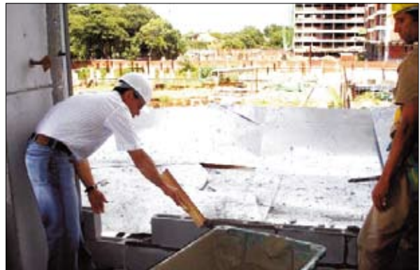
Figura 2 – Capacitação através de treinamento: a) no escritório com as equipes da obra e da ABCP, b) no canteiro – assentamento de argamassa com palheta
