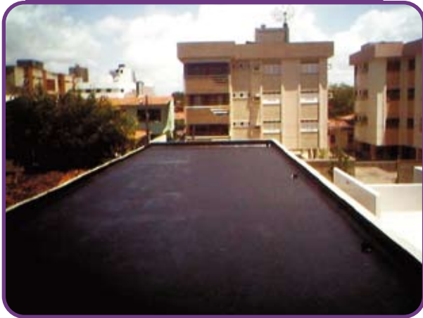
Figura 4 – Resina de Poliuretano aplicada em laje de cobertura de condomínio
