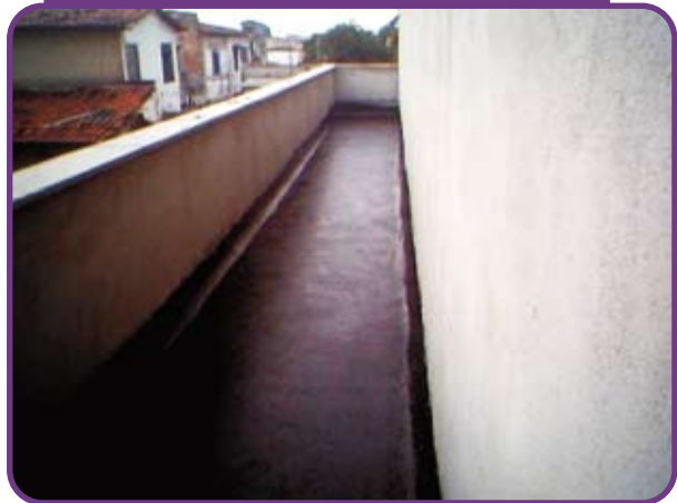
Figura 5 – Resina de Poliuretano aplicada em varanda de condomínio
