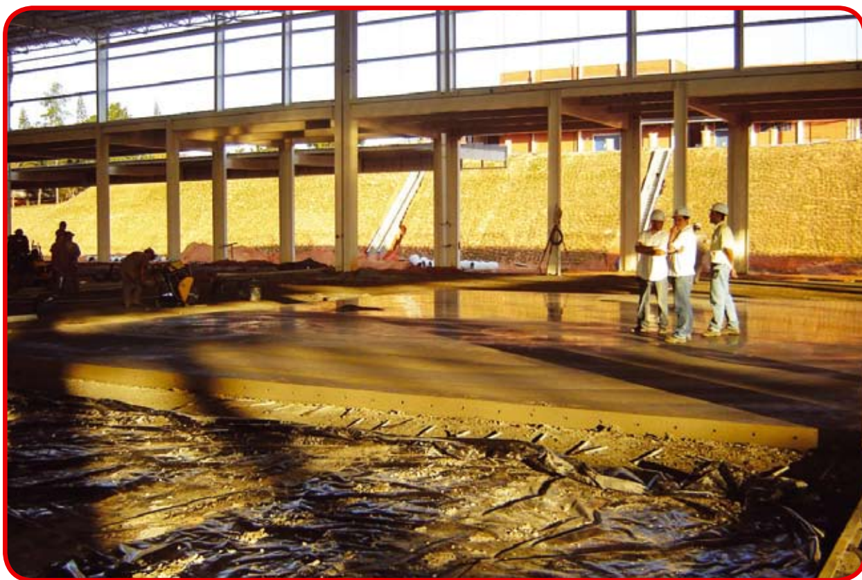
Obra de centro logístico para estantes porta paletes, empilhadeiras e cargas distribuídas, em execução com fibras mistas
