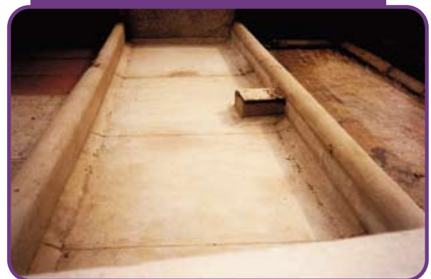
Figura 3 – Manta asfáltica aplicada em marquise do Estádio Machadão com proteção mecânica
