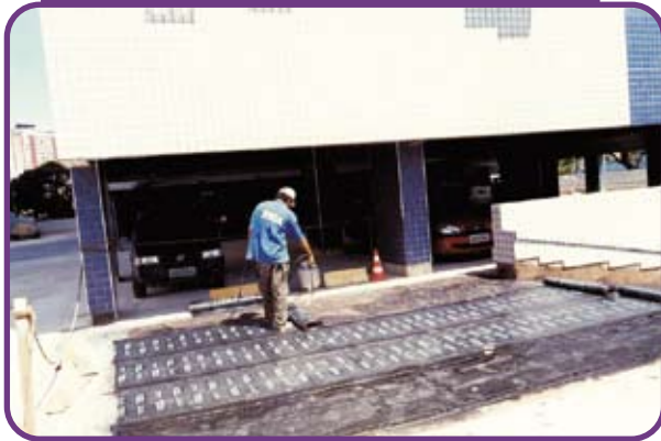
Figura 2 – Aplicação de manta asfáltica em lajes de piso (garagens) e rampa de acesso do condomínio
