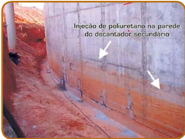
Figura 10 – Recuperação da parede do decantador secundário
