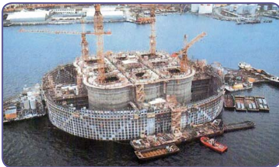
Figura 1 – Tanques de estocagem de petróleo de Ekofisk I e quebra-mar
