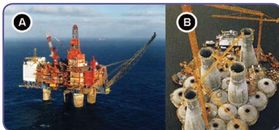
Figura 5 – Plataformas de concreto do tipo Condeep: (a) Gulfack C em operação; (b) Sleipner A em construção
