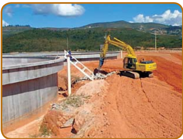
Figura 7 – Movimentação de terra
