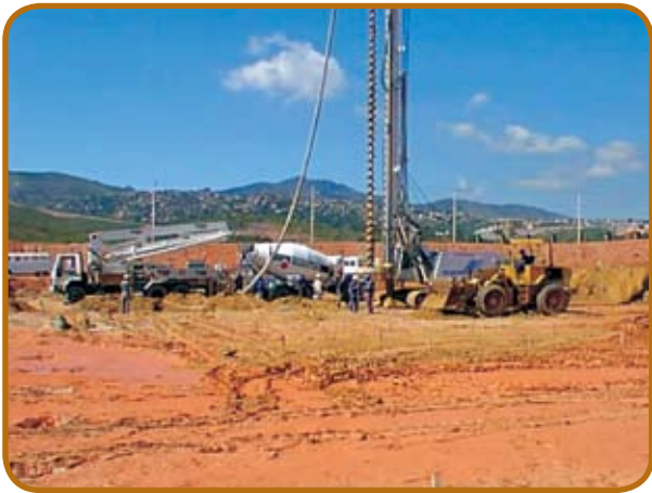
Figura 6 – Execução das estacas – Tanques de Aeração
