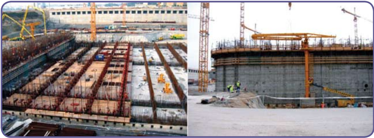
Figura 10 – Terminal LNG Adriático em construção em doca seca
