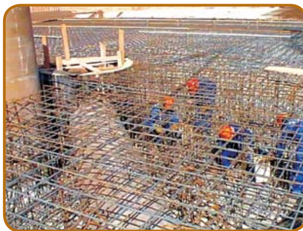
Figura 2 – Densidade de armadura
