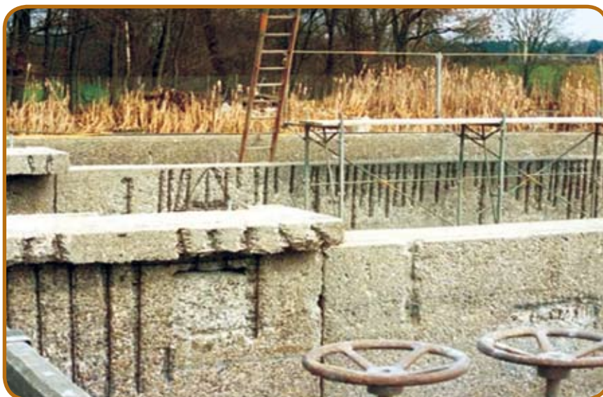
Figura 3 – Ataque de ácido sulfúrico biogênico
