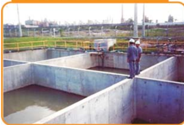
Foto 3.1 – Vista parcial dos tanques de decantação da CETREL, Camaçari, BA, 1991
