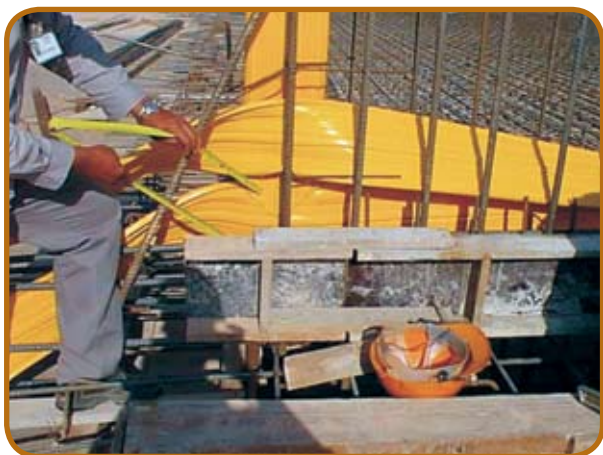
Figura 4 – Colocação da junta de dilatação
