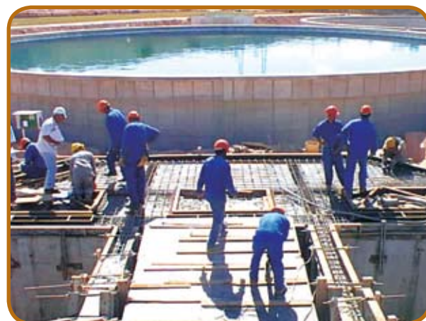
Figura 9 – Teste de estanqueidade – decantador secundário
