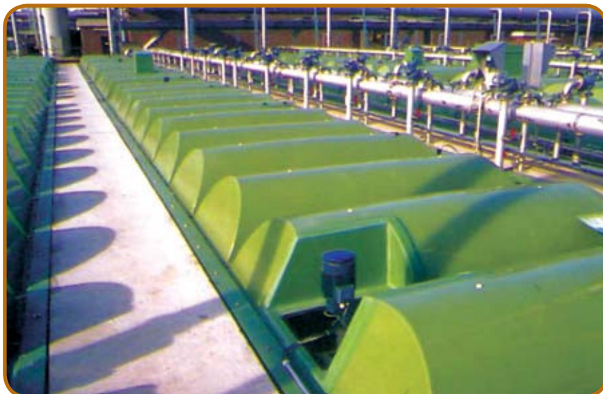
Figura 2 – Instalação de tampas sobre aeradores de esgoto
