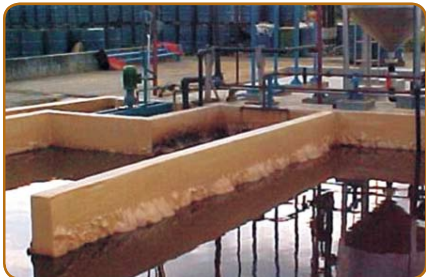
Figura 5 – Efeito de osmose em revestimento orgânico
