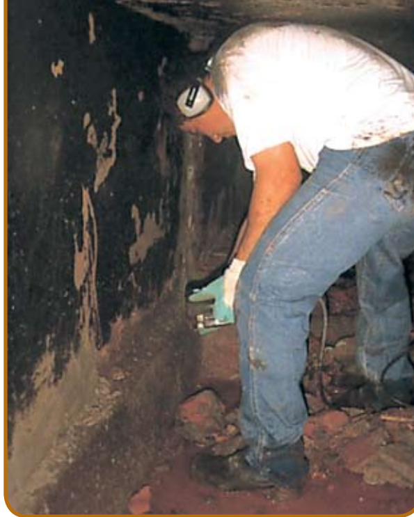
Figura 7 – Recuperação estrutural de canal de água filtrada em estação de tratamento de água – ambiente pouco iluminado e com dimensões reduzidas
