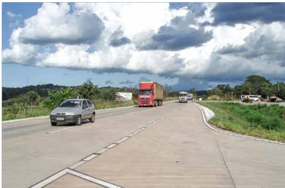
Pavimento de Concreto na Serra de São Vicente, com cimento CP-III
