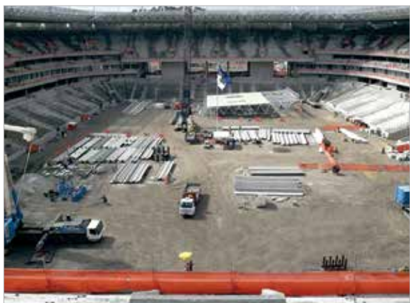
Figura 4 – Vista interna da obra no mesmo período (Fevereiro de 2013)
