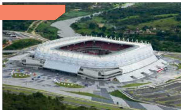
Figura 14 – Vista geral da Arena Pernambuco concluída
