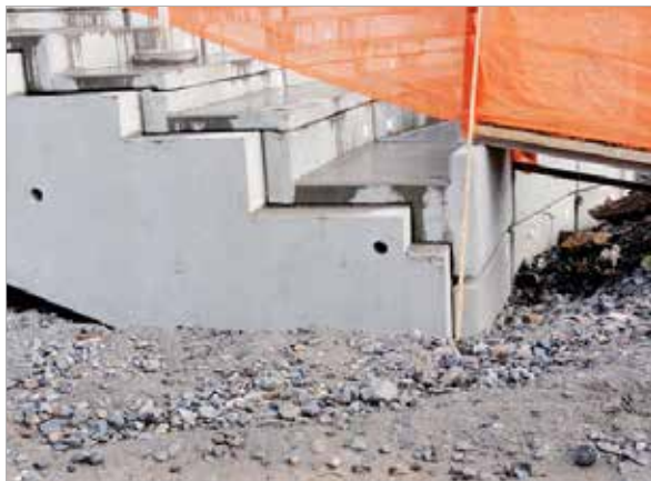
Figura 10 – Encaixe dos degraus com a viga-jacaré
