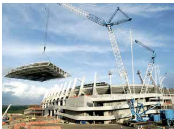
Figura 5 – Montagem da cobertura em treliça espacial
