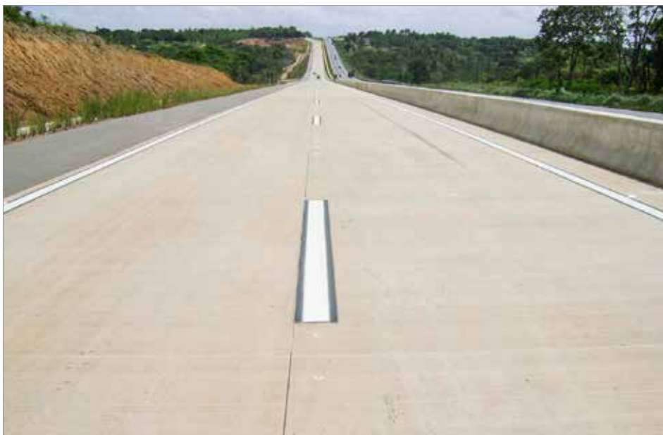
Pavimento de concreto da BR-101, com cimento CP-II Z
