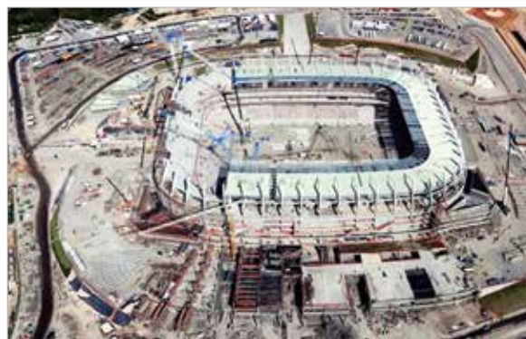
Figura 3 – Vista geral da obra em fevereiro de 2013
