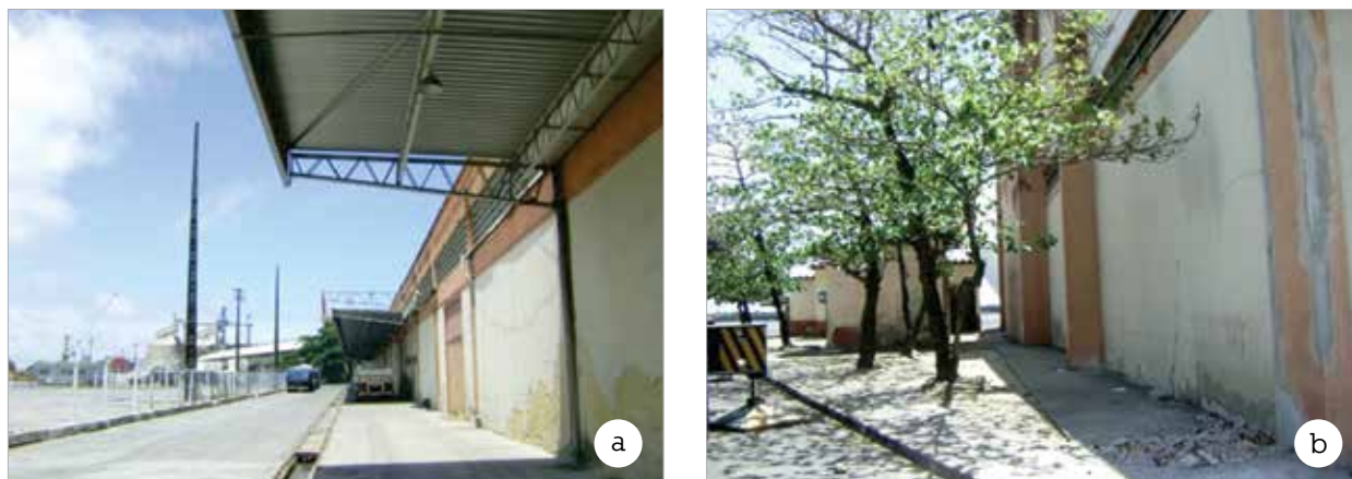
Figura 2.3 – (a) Fachada Oeste e (b) Fachada Norte
