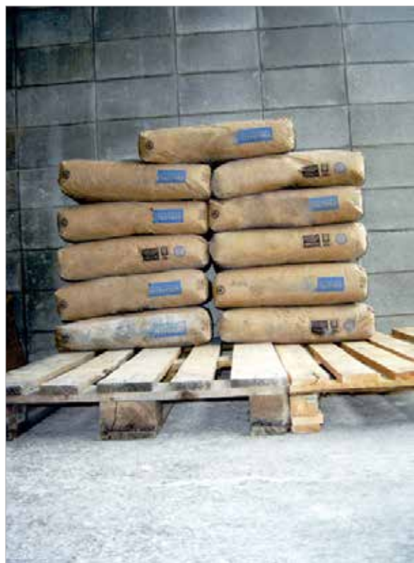
Figura 2 – Sacos de cimento estocados de forma correta
