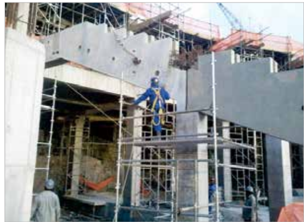
Figura 12 – Emenda da viga-jacaré
