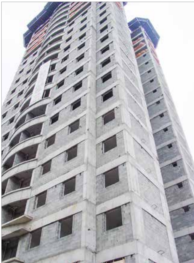
Estruturas de concreto do Edifício M. Bigucci, feitas com cimento CP-II E
