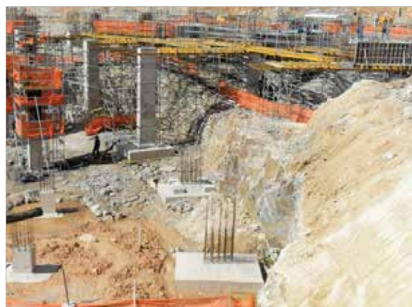
Figura 6 – Execução das sapatas
