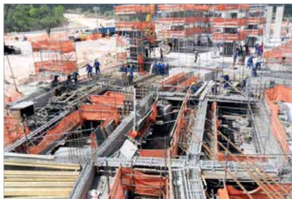
Figura 7 – Vigas e lajes sendo executadas
