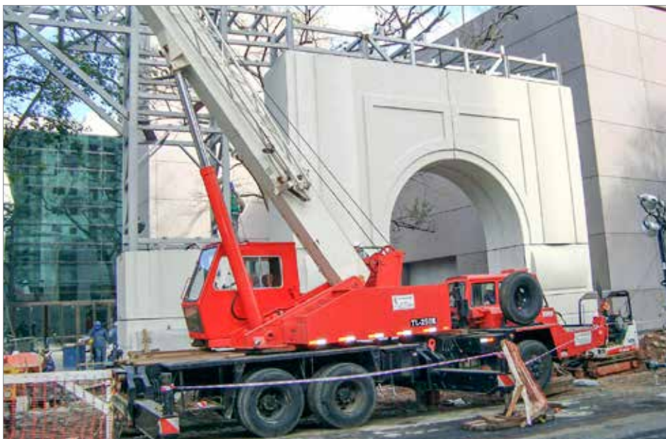
Pré-fabricados de concreto feitos com cimento CP-V
