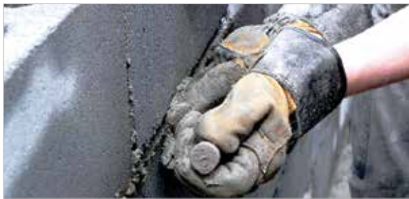
Figura 4 – Luvas de lona para assentamento de blocos de concreto
