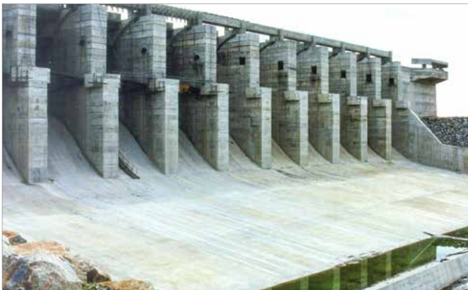
Detalhe das estruturas do vertedouro da Barragem de Castanhão, Ceará, feitas com cimento CP-IV
