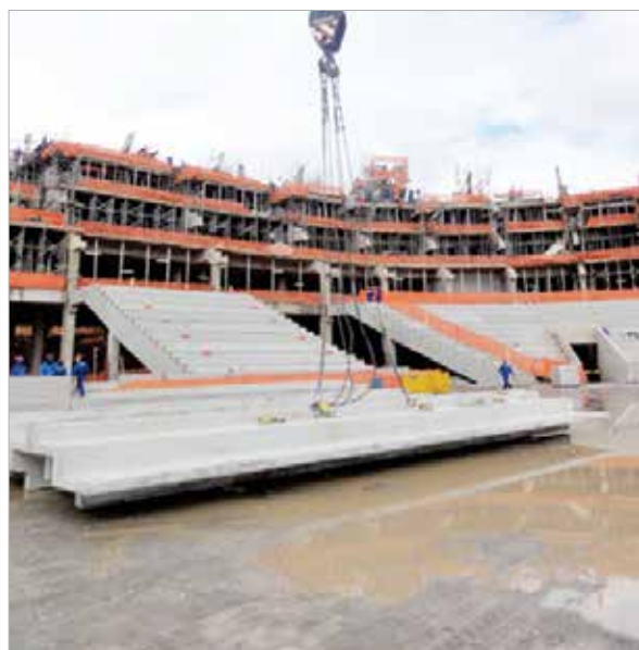
Figura 9 – Montagem dos degraus
