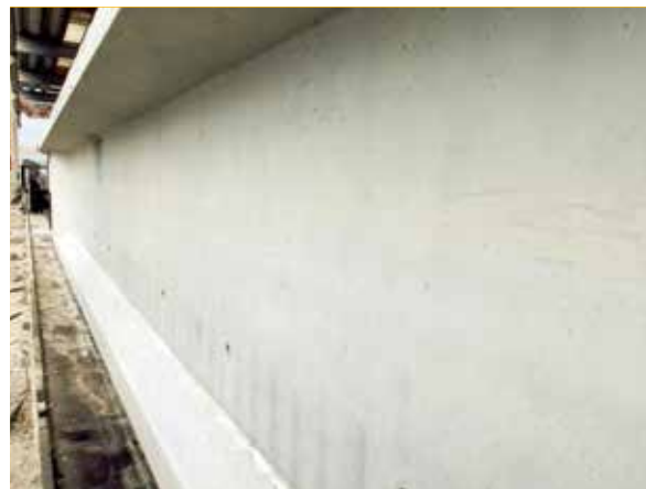
Figura 5 – Megaviga pré-fabricada após desforma sem acabamento (anterior a estucagem)
