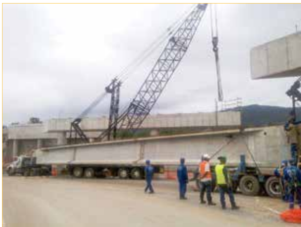
Figura 6 – Megaviga sobre o caminhão para descarga na obra
