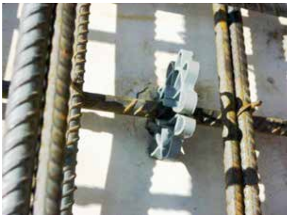
Figura 6 – Protótipos - espaçador fura a fôrma
