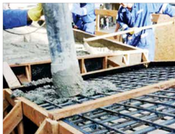
Figura 7 – Protótipos 1 e 2 antes e durante a concretagem
