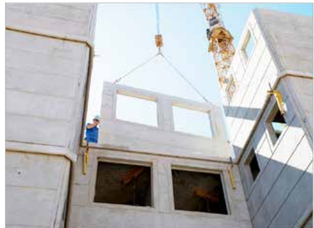
Montagem de painel pré-fabricado em edifício habitacional
