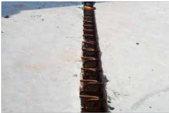
Figura 9 – Protótipo de sistema de “costura” de lajes
