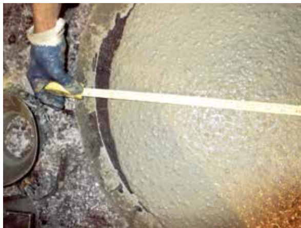
Figura 4 – Ensaio de controle através do espalhamento (slump-flow)
