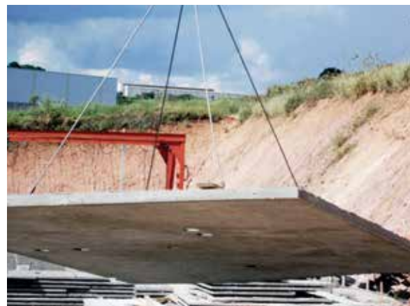
Figura 10 – Laje de concreto leve
