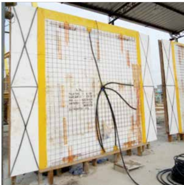
Figura 7 – Gabarito para a montagem dos sistemas dos painéis
