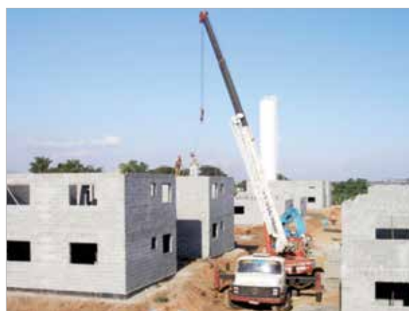
Figura 8 – Lançamento de laje pré-moldada
