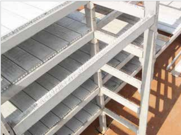
Estrutura pré-fabricada aplicada em edifício garagem composta por pilares, lajes alveolares e vigas
