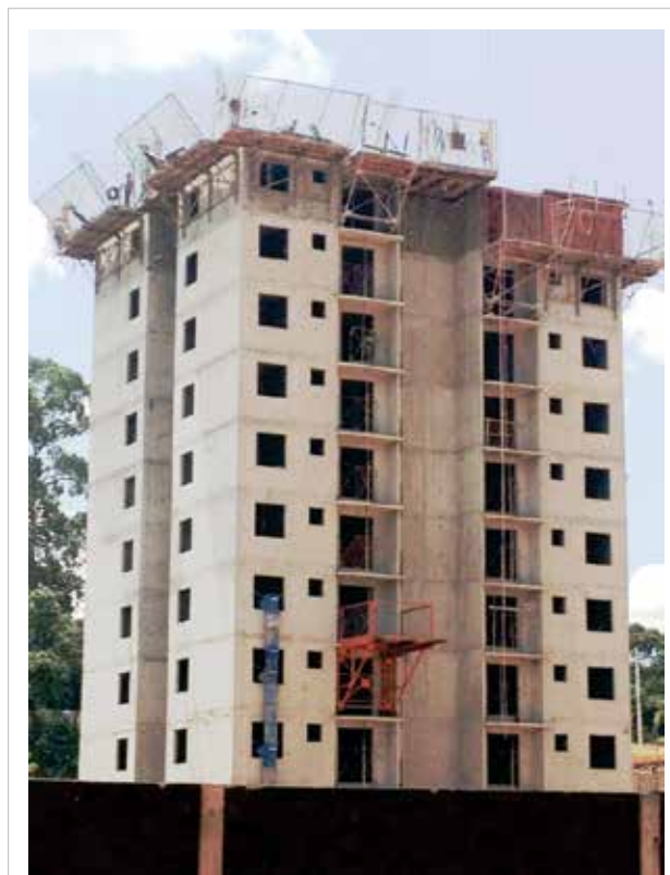
Figura 1 – Edifício Jardim Botânico em fase de construção – 10 pavimentos-tipo concretados
