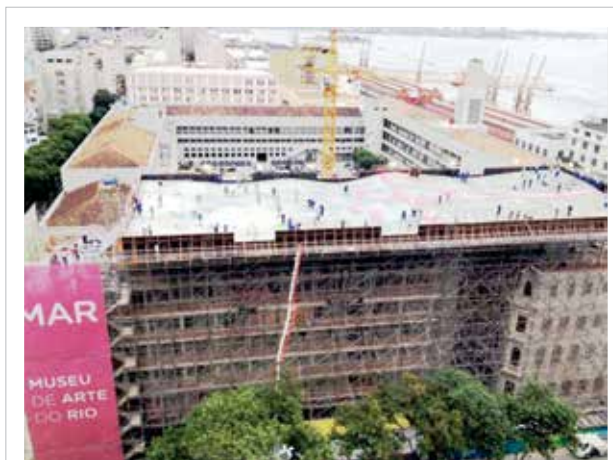
Figura 9 – Preparativos antes da concretagem
