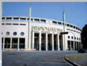
recuperação e reforço de edificações
