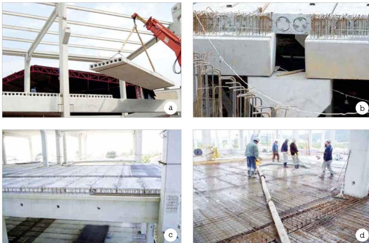
Figura 3 – Lajes alveolares: (a) içamento durante a montagem; (b) e (c) lajes montadas aguardando a colocação da armadura da capa estrutural; (d) concretagem da capa estrutural
