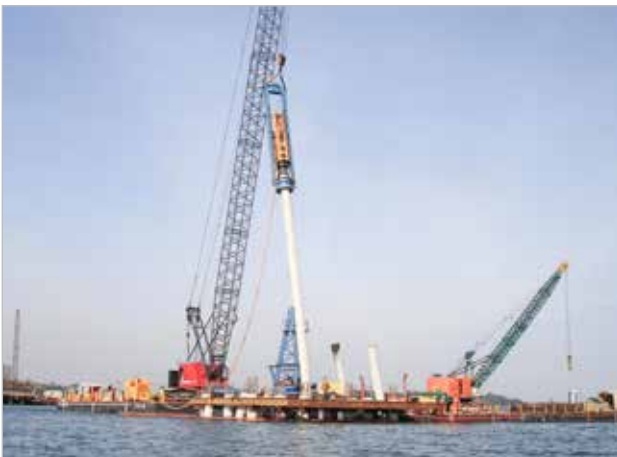
Aplicação de estacas pré-fabricadas em obras portuárias
