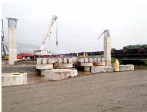
Figura 9 – Megavigas montada em obra ferroviária
