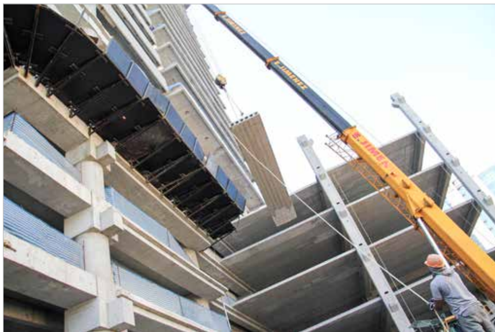
Montagem de lajes alveolares da mesma obra
