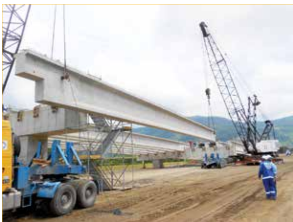
Figura 8 – Montagem das megavigas do viaduto duplo (rodoviário)
