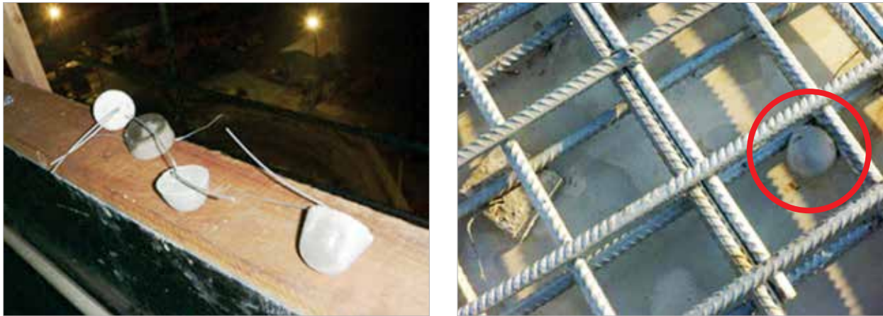
Figura 5 – Alguns formatos de espaçador testados. À direita, um deles “girado”
