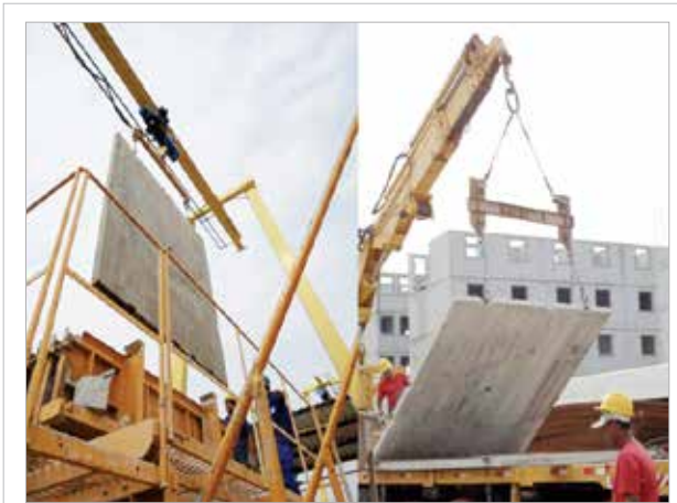
Figura 3 – Transporte e lançamento das lajes
