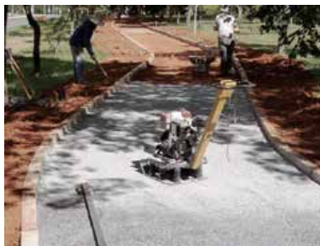
Figura 6 – Compactação da camada granular
