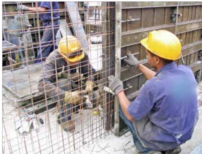
Montagem das fôrmas das paredes
