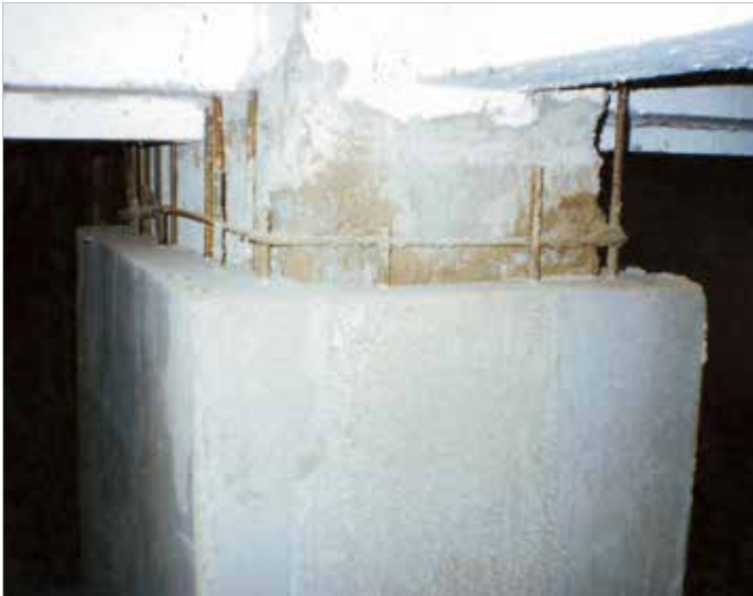
Detalhe da execução do reforço de um pilar
