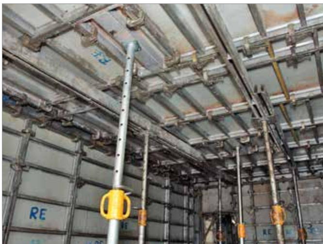
Fôrmas montadas - Construtora Mogmo em Valinhos
