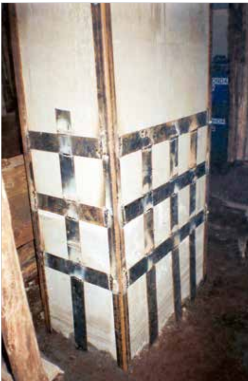
Segunda etapa de reforço de pilar
