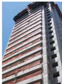
PAREDE DE CONCRETO
