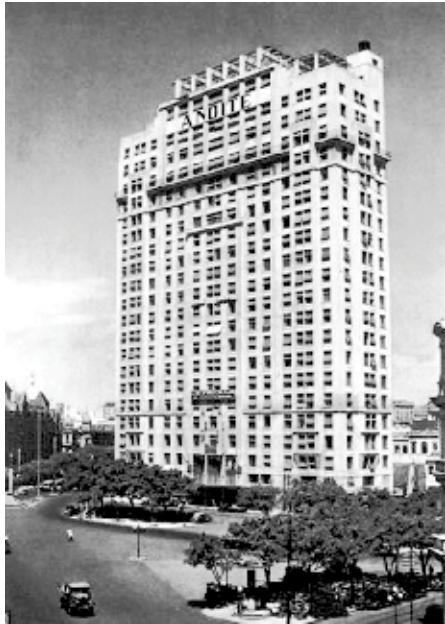
Figura 5 – Fachada no edifício “A Noite”, situado na praça Mauá, no Rio de Janeiro
