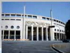
recuperação e reforço de edificações
