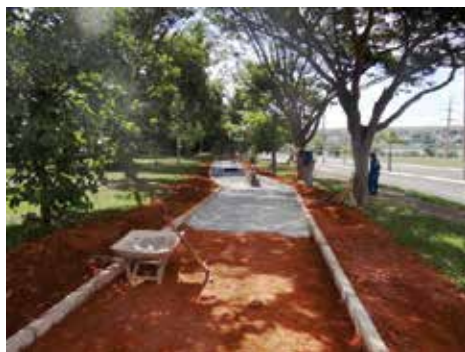
Figura 5 – Distribuição da camada granular
