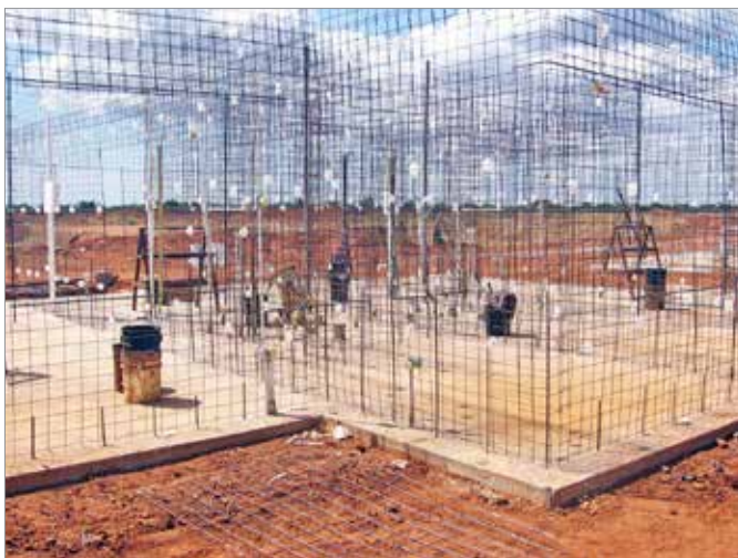
Vista da montagem das telas das paredes
