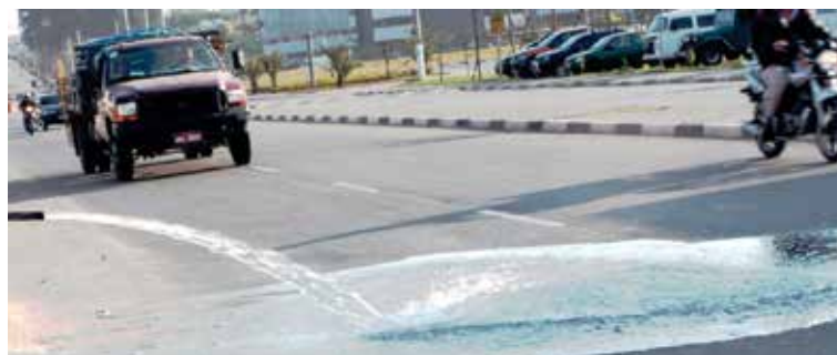
Figura 3 – Pavimento praticamente impermeável. Verifica-se a rápida formação de escoamento superficial da água
