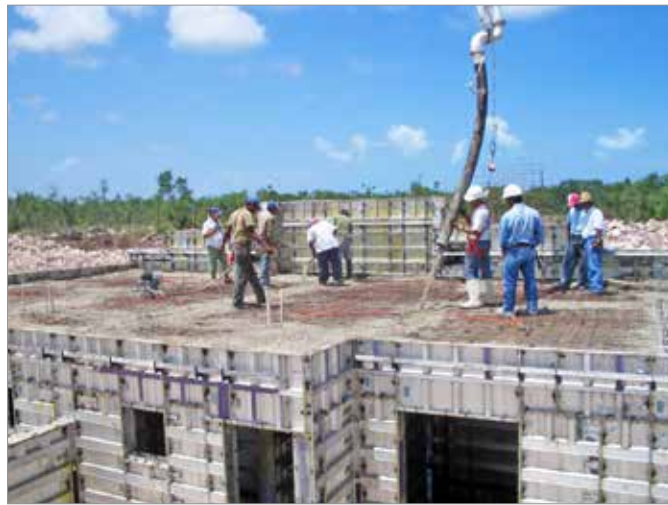
Concretagem da laje
