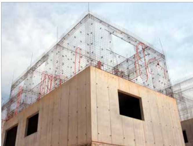
Aspecto das paredes desformadas com armação pronta no andar superior - Construtora Mogmo em Valinhos
