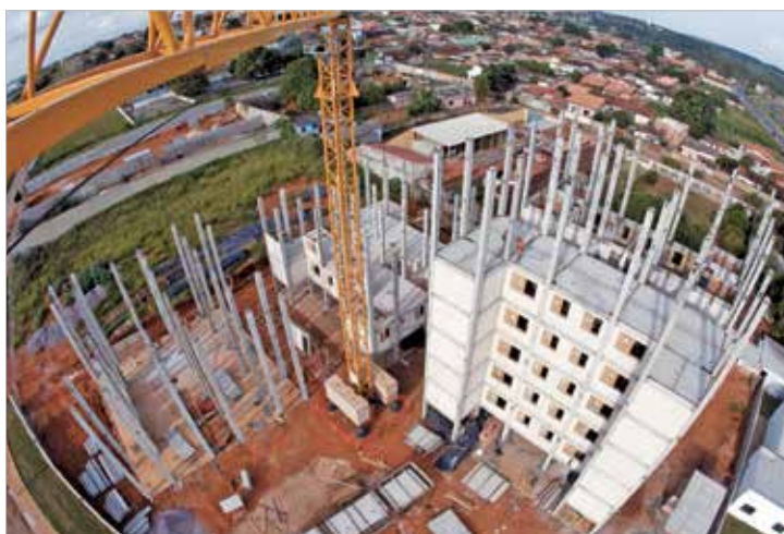
Figura 2 – Canteiro de obras em fase de montagem
