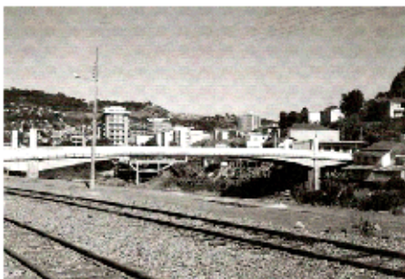
Figura 6 – Ponte Emílio Baumgart sobre o rio do Peixe em Santa Catarina
